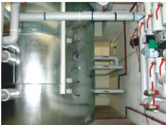
Abbildung 30: Einspeichersysteme reduzieren Kosten als auch Wärmeverluste entscheidend
