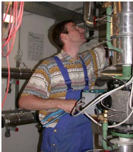
Abbildung 37: Auch Solarsysteme müssen regelmäßig (zumindest einmal jährlich) gewartet werden
