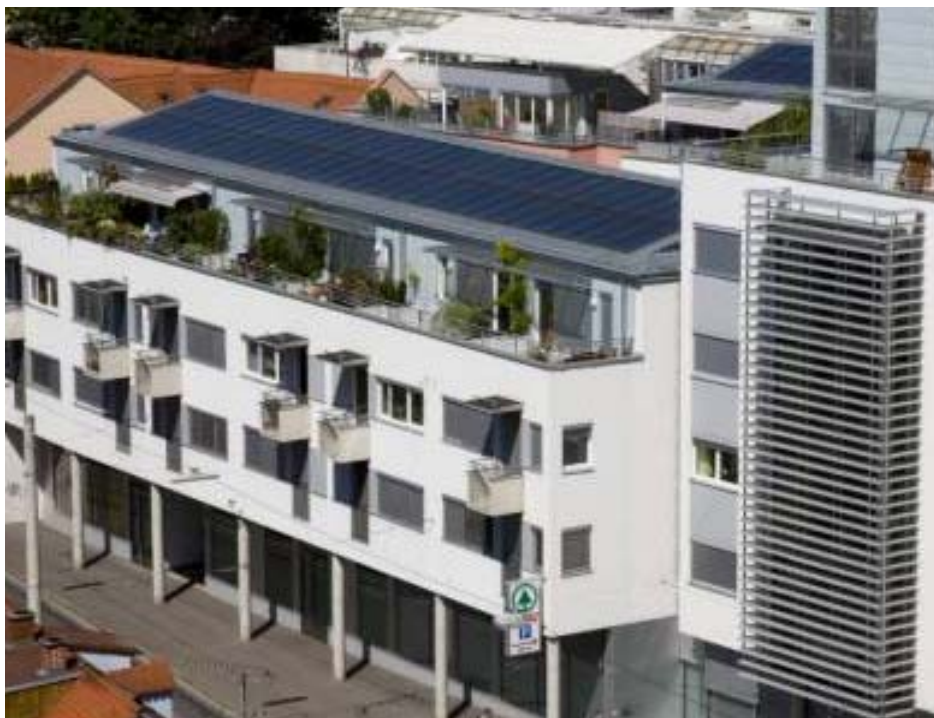
Abbildung 2: Solarwärmeanlagen haben sich als Standard im Neubau von Geschoßwohnbauten etabliert (Bildquelle: ENW, Graz).
