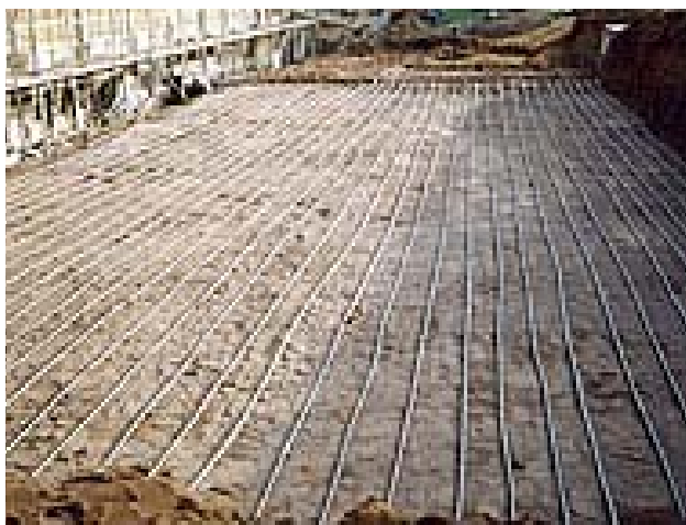
Bild 1.1 Verlegung eines Erdwärmekollektors aus Kunststoffrohrschnängen (Quelle: www.gesell-camburg.de/referenzen.html )
