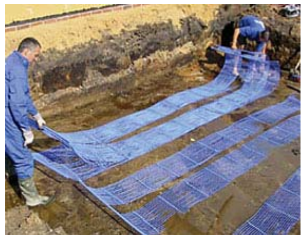
Bild 1.2 Verlegung eines Erdwärmekollektors aus Kunststoff-Kapillarrohrmatten (Quelle: www.clina.de/Bilder/Erkolektoren.jpg )
