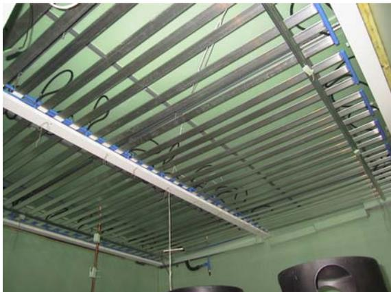
**Bild 10.14** Clina-Wärmeleitpaneele als thermisch aktives Grundsystem installiert im Prüfraum nach DIN 4715 an der Westsächsischen Hochschule Zwickau (FH)
