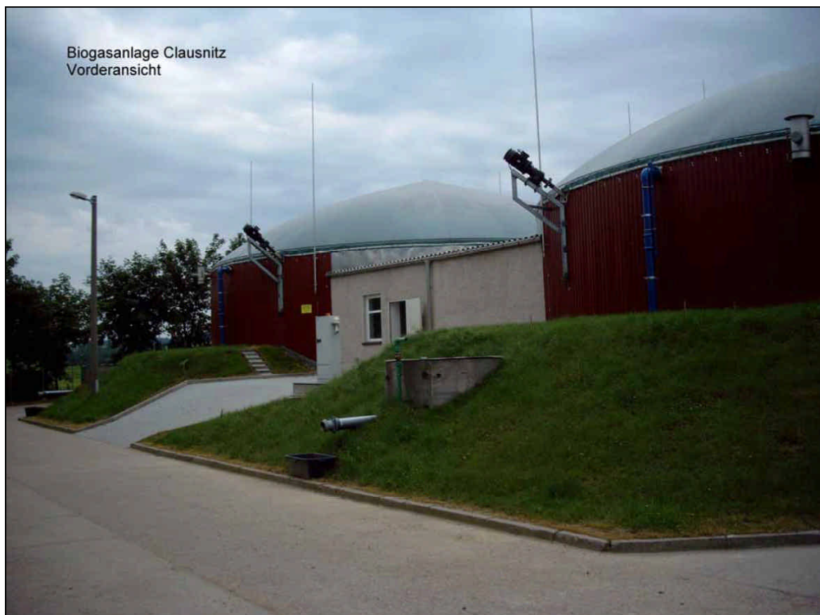
Abbildung 14: Nassfermenter BGA Clausnitz [16]
