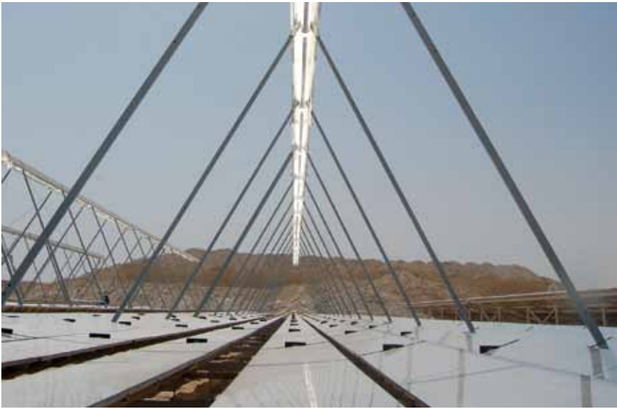
Fresnel-Kollektor zur Prozesswärmeerzeugung von 180 °C
