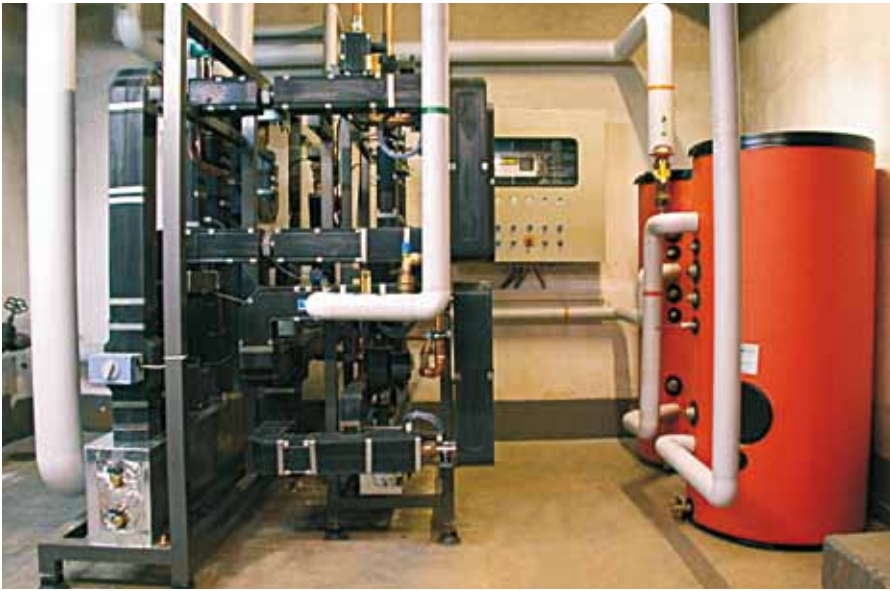
Vorgefertigte Hydraulikzentrale für Solaranlagen in Mehrfamilienhäusern
