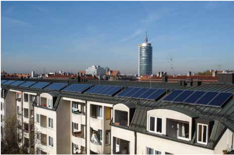
Solarthermische Anlage auf Wohnblock
