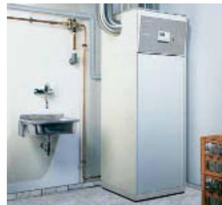
Zentrales Abluftsystem für die Lüftung mit einer Wärmepumpe zur Wärmerückgewinnung [F15]
