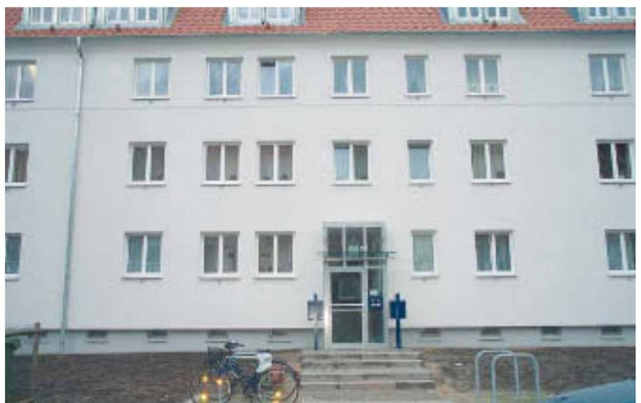
Für die Lüftung der Wohnungen wurde ein dezentrales Abluftsystem ohne Wärmerückgewinnung gewählt. An der Außenwand sind unter den Fenstern der Wohn- und Schlafzimmer die Außenlufteinlässe erkennbar [F11].
