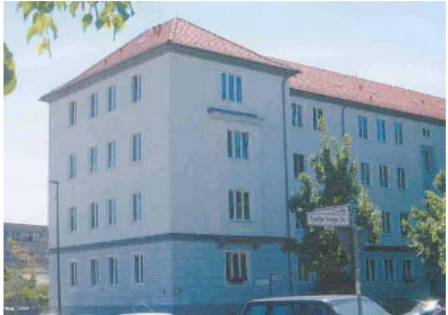
**Wärmetechnische Gebäudesanierung mit Folgen: Danach trat Schimmelpilzbefall auf. Der Einbau von dezentralen Abluftanlagen brachte Abhilfe [F12].**
