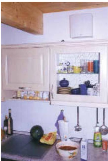
Dezentrales Abluftsystem ohne Wärmerückgewinnung: Abluftventilator an der Küchenwand (oben) [F11]
