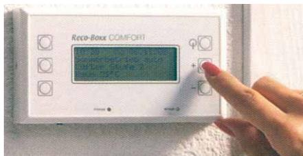
**Die Regelung des Lüftungssystems verfügt neben einem Automatikmodus auch über einen manuellen Modus. Dabei ist ein Sommer-/Winter-Betrieb sowie ein veränderlicher Lüfterbetrieb möglich [F12].**
