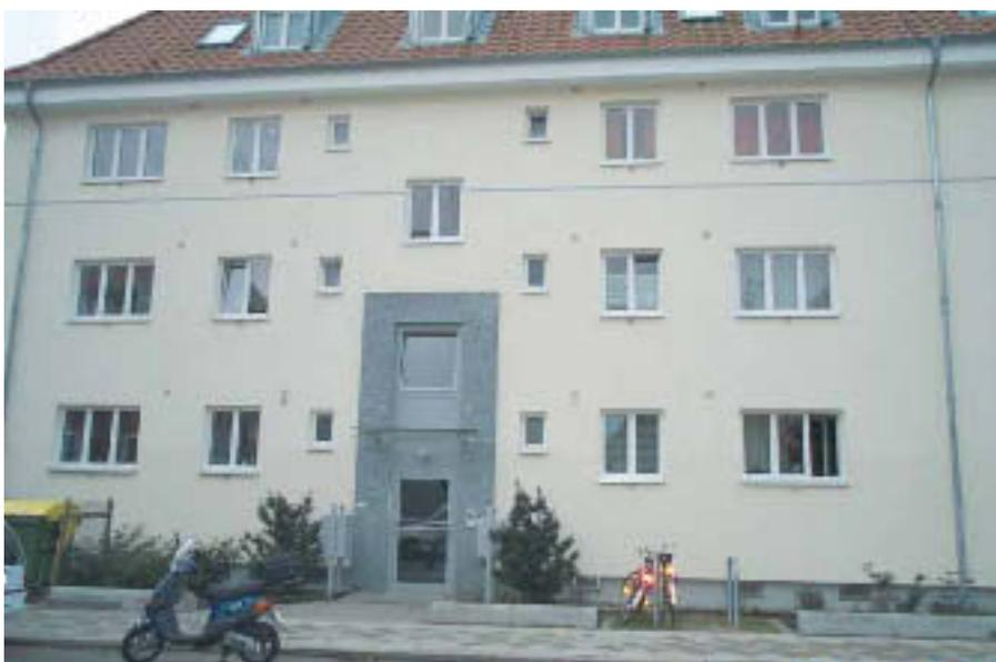
**Zur energetischen Sanierung der Außenfassade wurde ein Wärmedämmverbundsystem mit 12 cm Dämmdicke aufgebracht. Weiter wurden wärme- und schalldämmende Fenster eingebaut [F11].**
