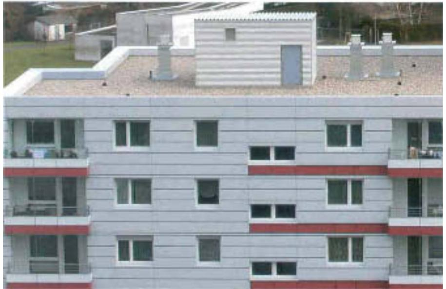
**Die Sanierung von drei großen Wohngebäuden in Karlsruhe umfasste Dächer, Fassaden, Fenster, Türen, Heizungsanlagen und die Lüftungstechnik [F12].**
