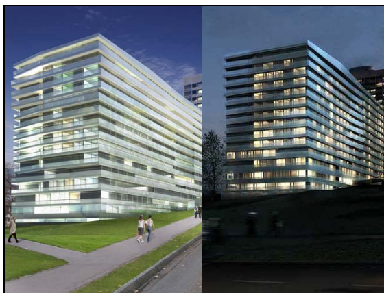
Abbildung 11.8: Neubau des Bettenhauses des Stadtspitals Triemli im Minenergie-P-Standard Quelle: www.stadt-zuerich.de
