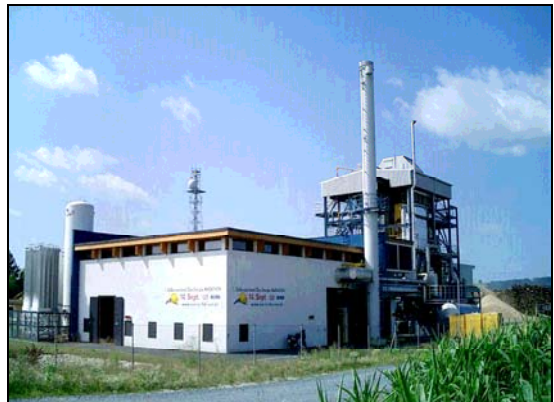
Abbildung 11.7: Biomasse – Heizkraftwerk Güssing Quelle: repotec
