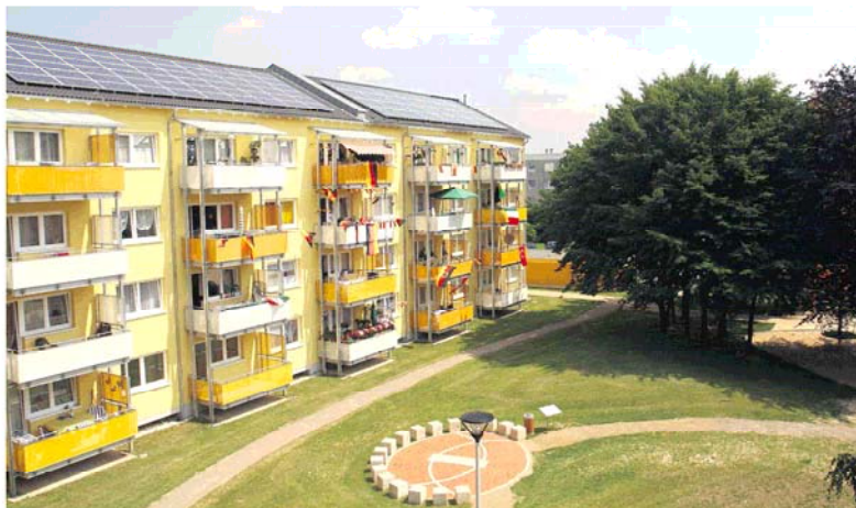
Südlöck der SolarSiedlung Ossendorf nach der Komplettanfertigung mit Photovoltaik und solarthermischen Dachkollektoren, wärmetechnisch isolierten vorgesetzten Balkonen und „sonnigen“ Fassadenanstrich. Foto: Graw/GAG
