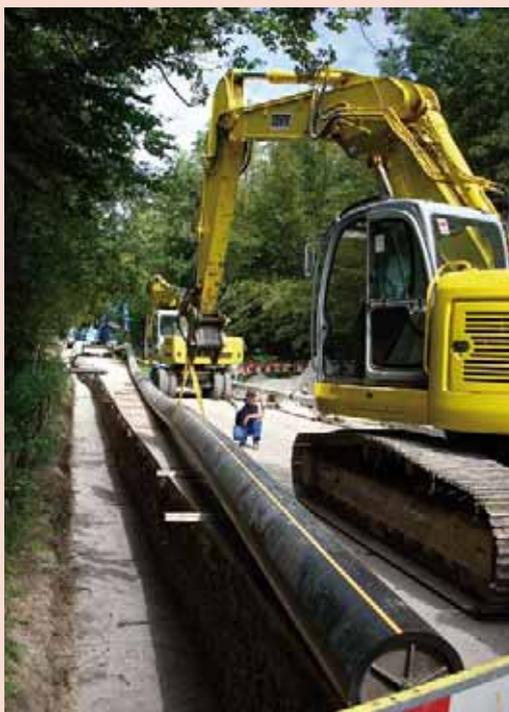
**Abbildung 15: Energiebalance in der Praxis.** In Mosbach wird eine neue, rund zwei Kilometer lange Biogasleitung installiert, die das regenerative Gas dahin transportiert, wo Wärme benötigt wird. Dadurch steigt der Nutzungsgrad der Anlage. Gleichzeitig muss das Biogas nicht energieaufwändig aufbereitet und in das Erdgasnetz eingespeist werden.
