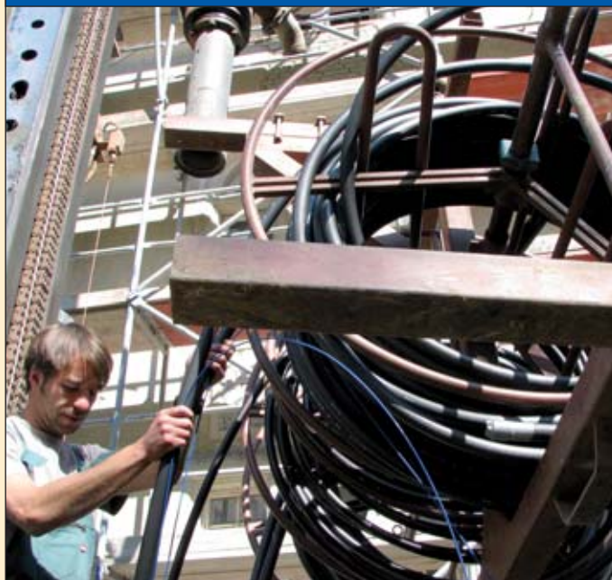
Abb. 4: Neue Sondenmaterialien verbessern den Wärmeübertrag
