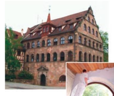
Abb. 43 Innendämmung der Fassade eines denkmalgeschützten Gebäudes
