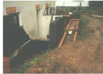
Bild 3: Zwei parallele Erdwärmetauscher-Rohre 2 m neben dem Fundament
