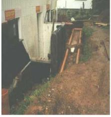
Bild 3: Zwei parallele Erdwärmetauscher-Rohre 2 m neben dem Fundament
