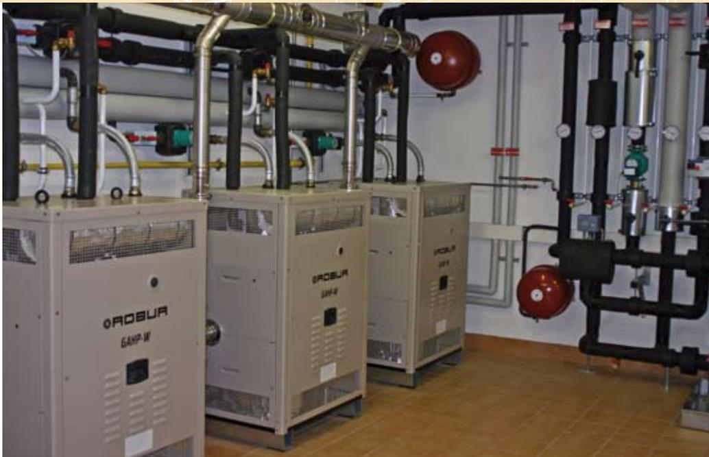
■ Bild 1: Die vierstufige Gas-Absorptionswärmepumpenanlage steht mit einem 170 m<sup>3</sup> großen, im Erdreich versenkten Latentwärmespeicher in Verbindung und bildet die Basis der Wärme- und Kälteerzeugung.
