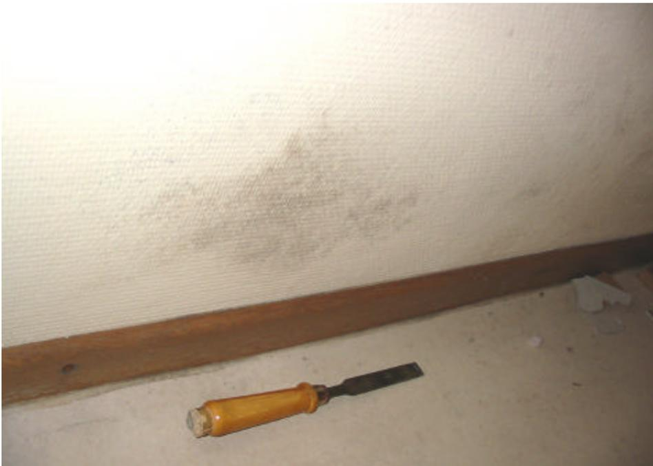
Abb. 9: Schimmelpilzbefallene Aussenwand mit  $< 0,5 \text{ m}^2$  Fläche
