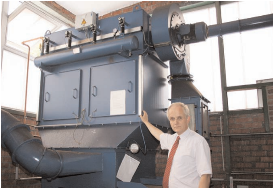
Firmenchef Wengeler investierte in Energieeffizienz: Durch den Einsatz hochwirksamer Filter in dieser Anlage kann die warme Luft nun im Winter zur Hallenbeheizung genutzt werden.
