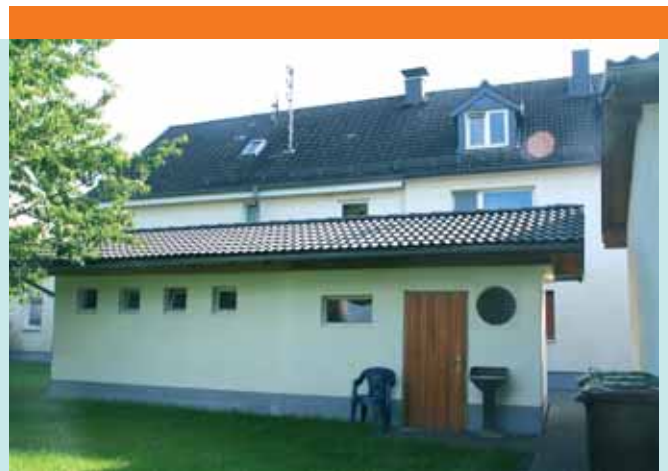
Gerätehaus mit Luftaustrittsöffnung
