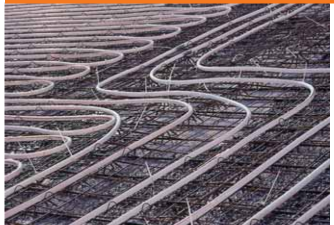
Rohrsystem zur Betonkerntemperierung Foto: Repp GmbH
