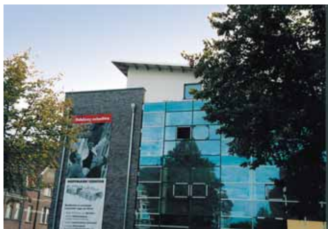
Seitenansicht des Gebäudes Foto: Repp GmbH
