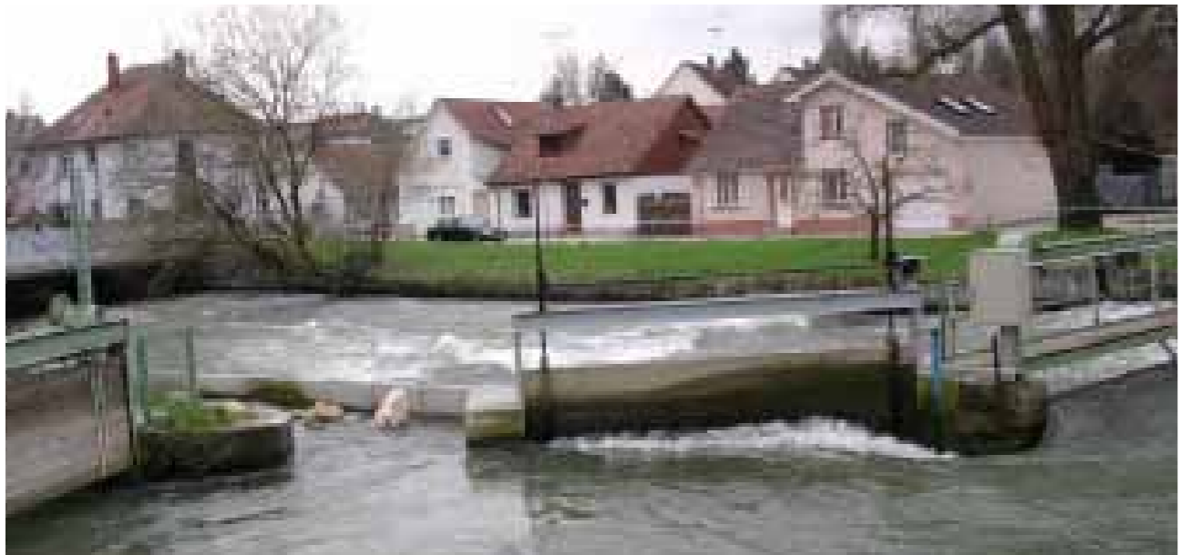
50 Reaktivierte Wasserkraftanlage an der Radolfzeller Aach
