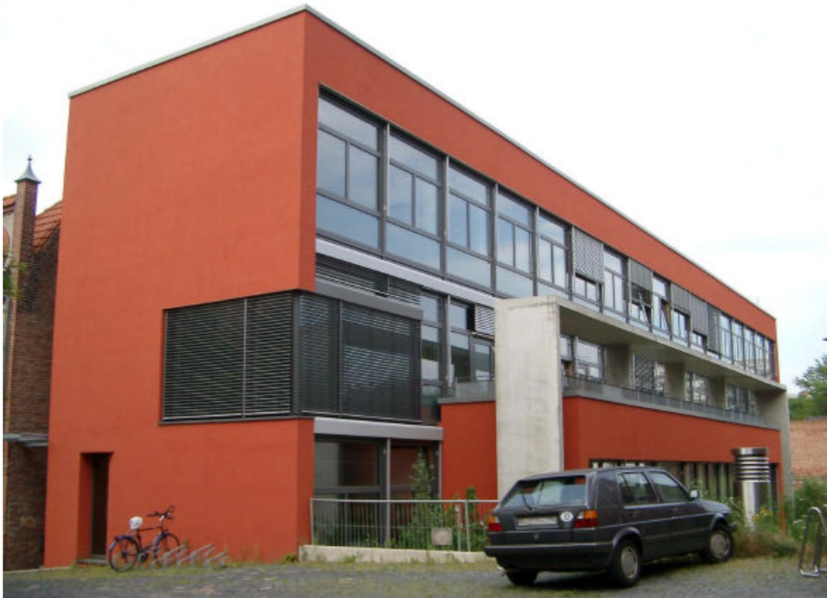
*Grafik 3.2.1 Der ZUB-Neubau an der Universität Kassel mit seiner nahezu vollverglasten, nach SSO orientierten Fassade. Der vermessene kleine Hörsaal befindet sich im Erdgeschoß.*
