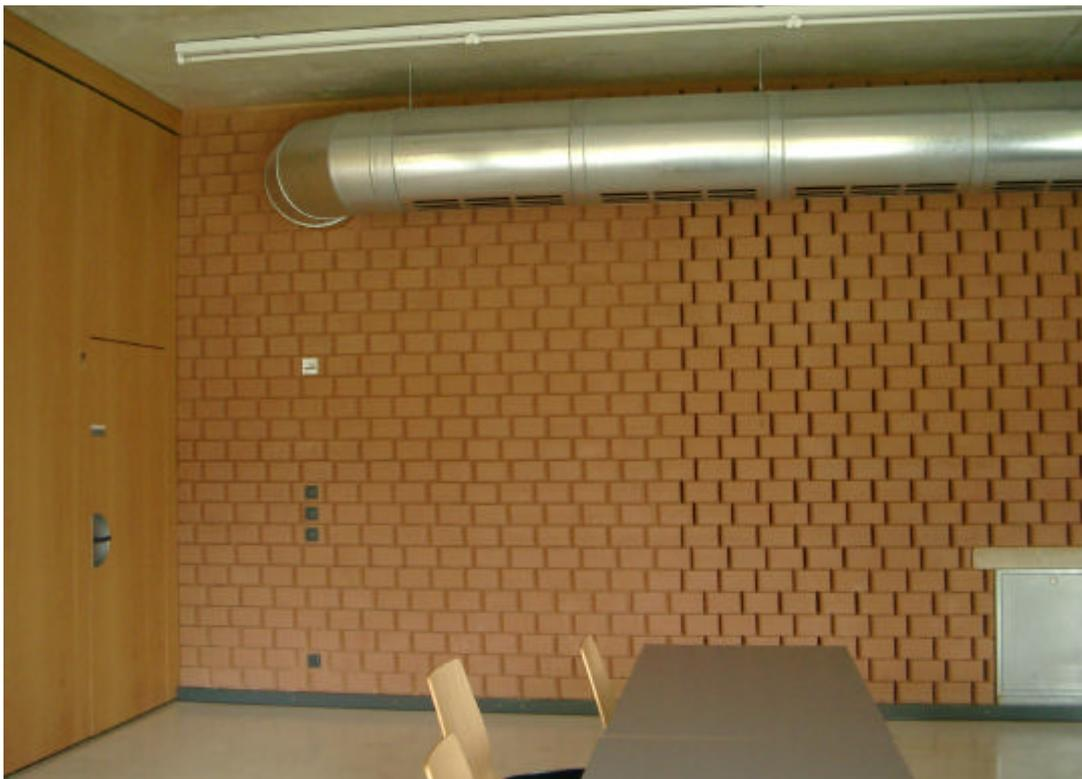
Grafik 3.2.3 Die Lehmziegelwand im ZUB-Hörsaal, links mit geschlossenen Fugen, rechts mit offenen vertikalen Fugen als Helmholtzresonator ausgebildet..
