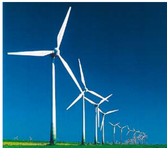
Windpark Friedrich Wilhelm Lübke-Koog vor dem Repowering
