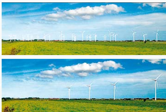
Windenergieanlage Bassens (Landkreis Wittmund) vor und nach dem Repowering
