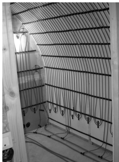
Abb.3 Wandheizsystem für Nassverlegung
