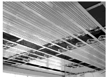
Abb.5 abgehängtes Deckenheiz-/kühlsystem
