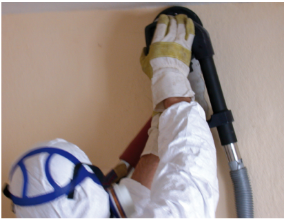
Schimmelpilzsanierung mit Putzfräse
