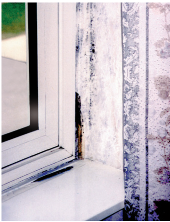
Schimmelpilzbefall in der Fensterlaibung
