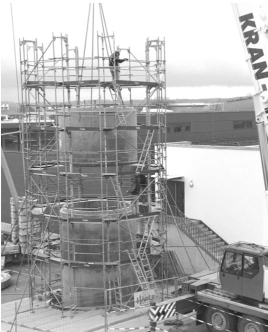
Bild 2: Bau des 100 m<sup>3</sup>-Pufferspeichers in Crailsheim im Jahr 2004
