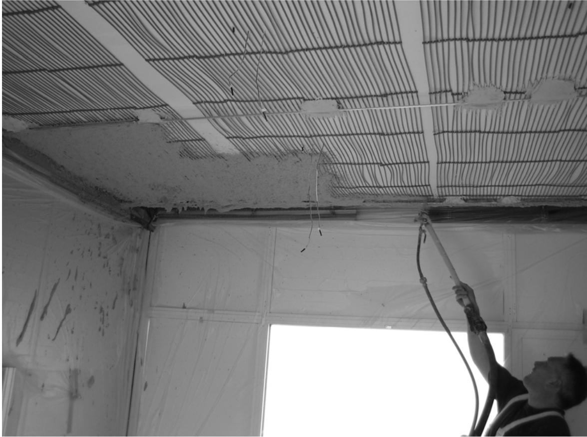
Abbildung 5 - Einbau einer PCM-Kühldecke in Testräume am Fraunhofer ISE
