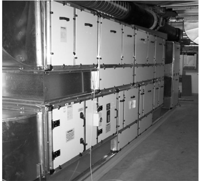
Abbildung 7: Zwei indirekte Verdunstungskühler der Howatherm Klimatechnik
