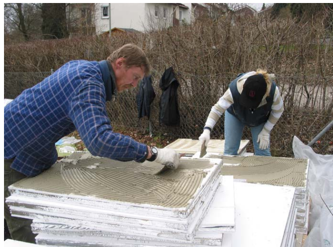
Aufbringung des Klebemörtels
