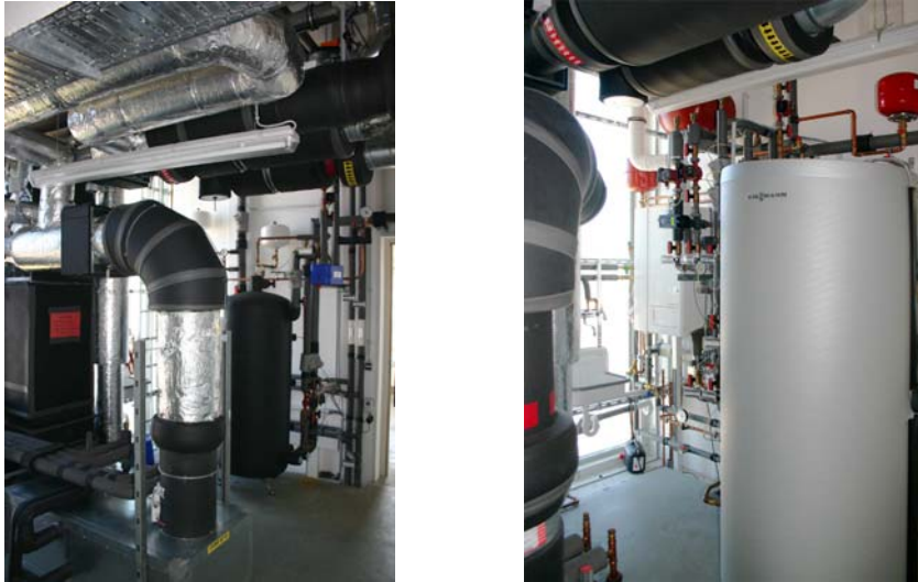
Bild 3 Zentrale Technikbereiche des Versuchsgebäudes.
