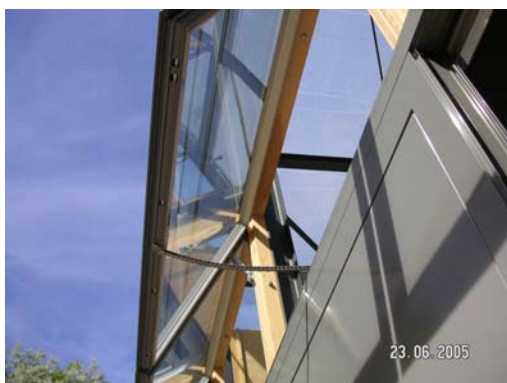
Bild 6: Zuluftöffnungen für das Atrium
