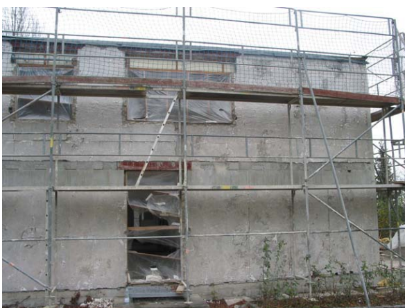
Fassade vor Anbringung der VIPs
