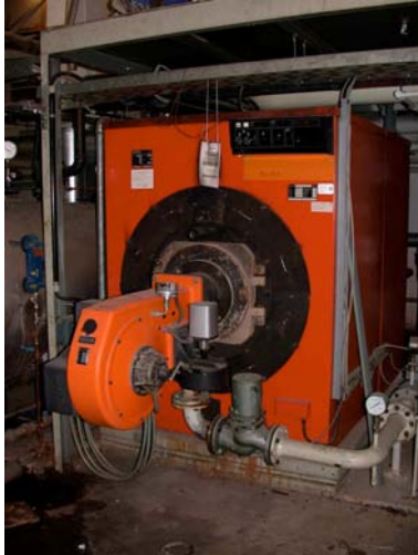
2 Gaskessel mit 1800 kW
