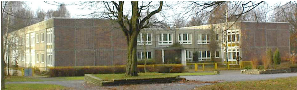
Bild 1: Ansicht der Kindertagesstätte vor der Sanierung
