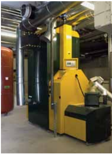
Pelletheizungsanlage
