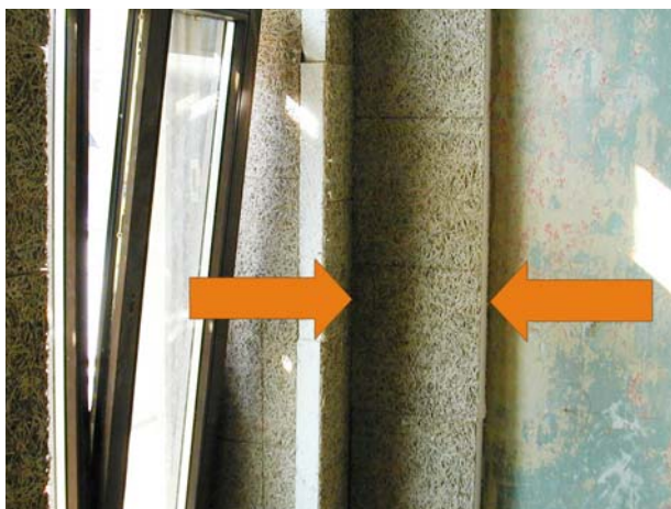
Dämmung einbindender Innenwände und Massivdecken mit einer 40cm breiten Dämmschürze
