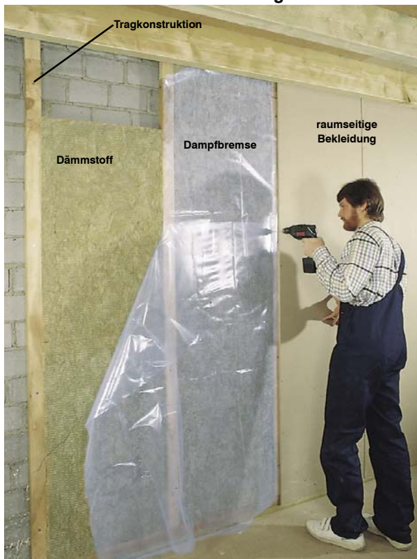
Schichtaufbau einer Innendämmung - eine Dampfbremse als separates Bauteil ist nicht bei allen Systemen erforderlich.
