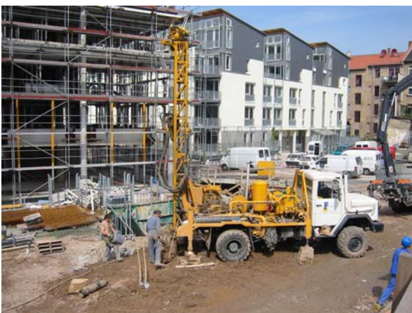
Bohrung für die Erdwärmesonden einer Wärmepumpe
