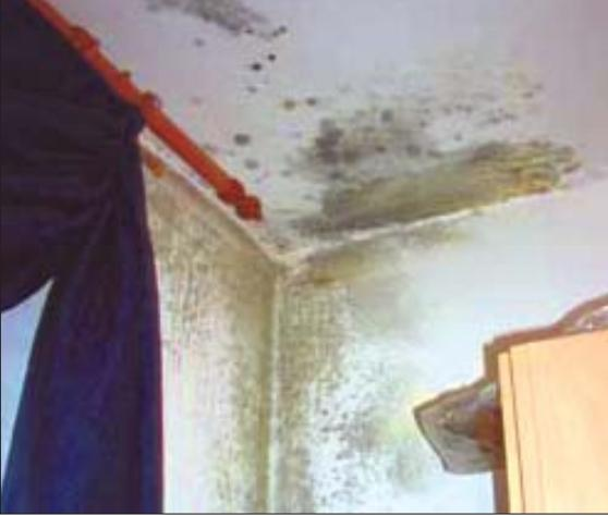
*Gutes Lüften verhindert die Entstehung von Schimmel an Wänden und Decken. Anti-Schimmel-Sprays helfen bei solch einem Befall nur vorübergehend. Erst wenn die Ursache der Feuchtigkeit beseitigt wird, verschwindet der Schimmel dauerhaft.*
