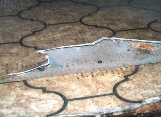
*Solche beschädigten CV-Böden gehören unverzüglich asbestsaniert.*
