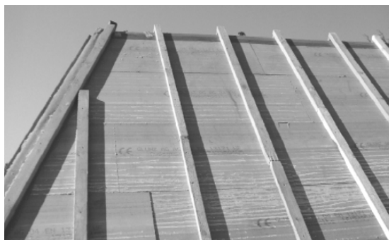
Abbildung 13: Aufsparrendämmung
