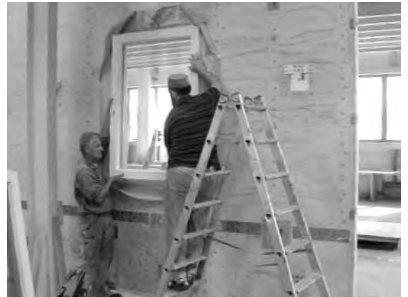
Abbildung 47: Einbau Fenster in GEDT-Element
