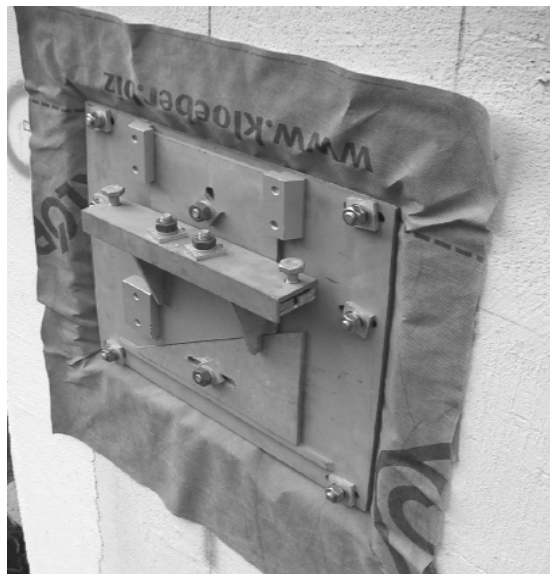
Abbildung 42: Winddichtigkeit an E-Befestiger
