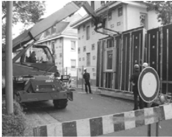
Abbildung 55: Montage mit Hubstapler
