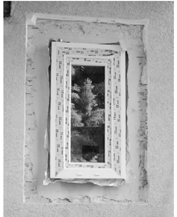
Abbildung 20: Fenstereinbausituation mit Rückschnitten des alten WDVS
