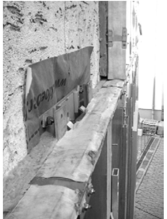
Abbildung 58: Zwischenstand Montage unteres GEDT
