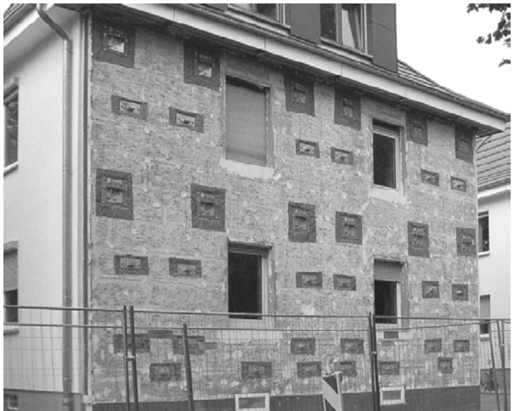
Abbildung 41: Fassadenseitige Befestigungselemente für das GEDT
