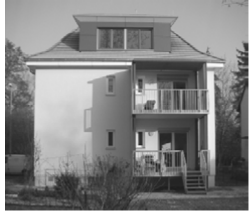
Abbildung 3: Südansicht MFH Wilhelmstraße nach Sanierung
