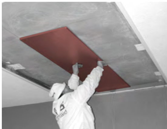
Abbildung 29: VIP-Einbau an Kellerdecke [Bild Fa. Va-Q-Tec]
