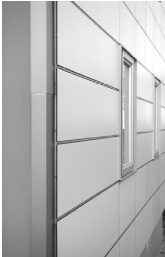
Abbildung 59: Ecksituation GEDT Fassade
