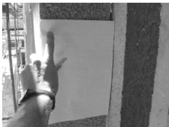
Abbildung 16: Zusätzliche Außenwanddämmung
