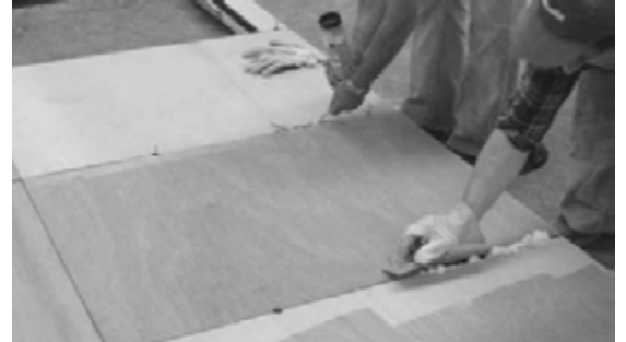
Abbildung 43: Ausschäumen der VIP-Fugen
