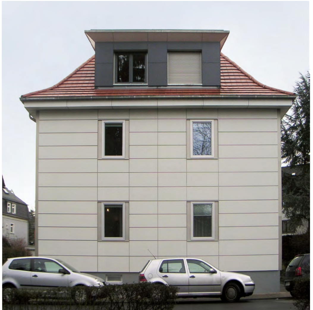
Abbildung 61: Ansicht Straßenseite nach Fertigstellung
