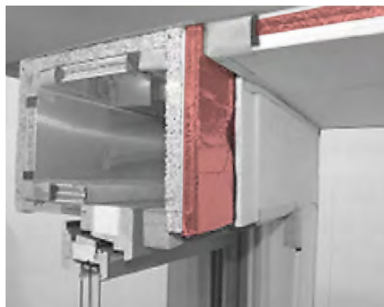
Abbildung 30: VIP-Einbau Rollladenkasten [Bild. Fa. Variotec]
