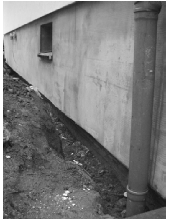
Abbildung 19: Zusätzliche Sockeldämmung
