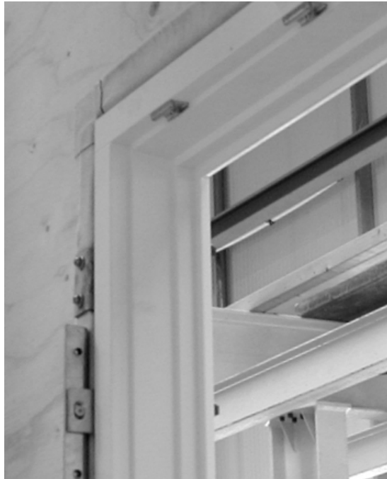
Abbildung 49: Fensterbefestigung in Kerto-Platte
