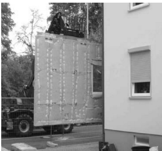
Abbildung 57: Rückseite GEDT mit Fülldämmung
