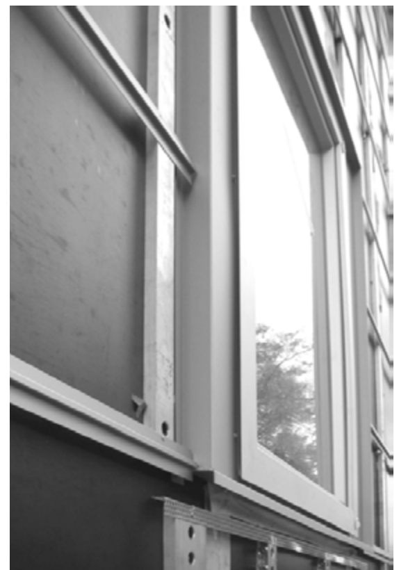
Abbildung 48: Fenster im GEDT ohne Fassadenbekleidung
