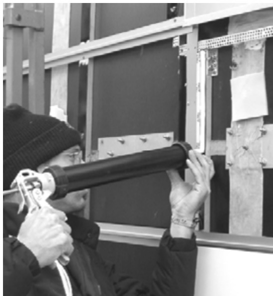
Abbildung 50: Verklebung Fassadenbekleidung
