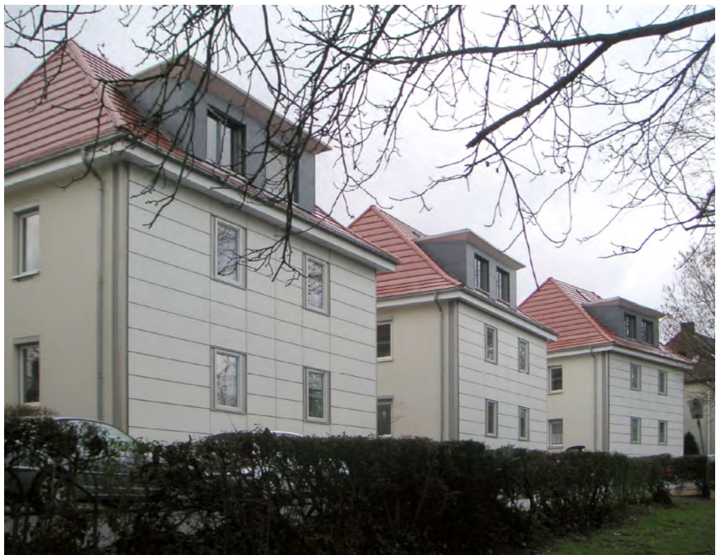
Abbildung 26: Gesamtansicht nach der Sanierung
