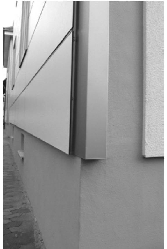
Abbildung 53: Eckanschluss GEDT und WDVS-Fassade
