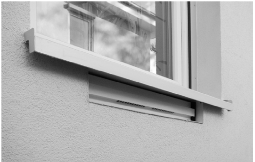
Abbildung 24: Zuluftelement unter Fensterbank
