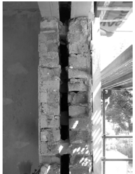
Abbildung 15: Doppelschaliges Mauerwerk im Bestand
