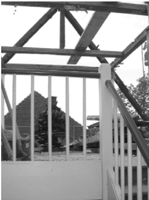
Abbildung 11: Abrissarbeiten Dachstuhl
