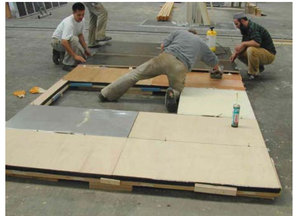
Abbildung 7.3-12 Verkleben der BFU-Platten auf die VIPs
