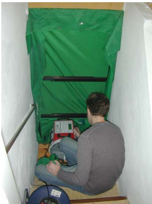
Abbildung 3.2-11: Drucktest – Luftfördereinrichtung im Kellerabgang eingebaut
