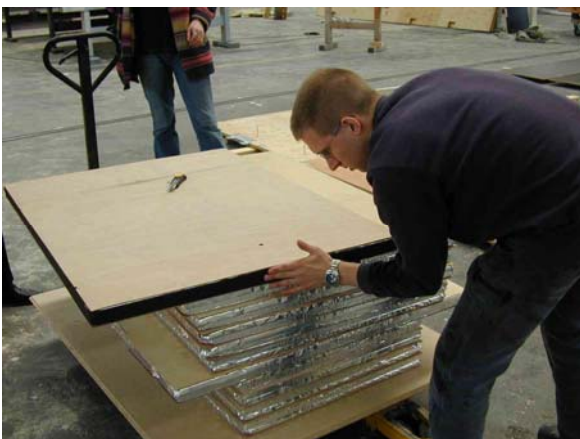
Abbildung 7.3-2 Aufkleben des Kompribandes vor dem Verkleben der „eingehausten“ VIPs
