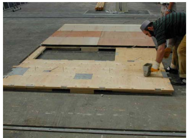
Abbildung 7.3-10 Auftragen des PU-Klebers auf die Kerto-Platte
