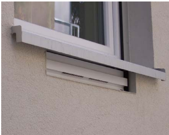
Abbildung 2.5-6 Fensterbanklüfter im eingebauten Zustand
