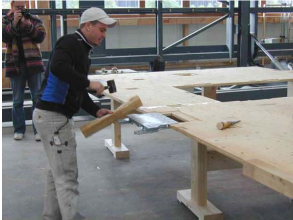
Abbildung 7.3-7 Montage des E-Punktes in die Kerto-Platte
