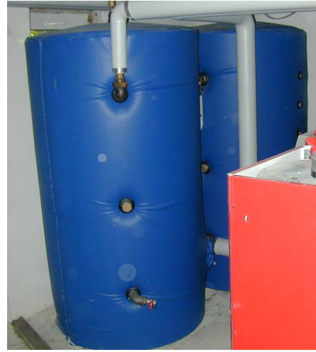
Abbildung 2.5-4 Puffer- speicher während der Montage
