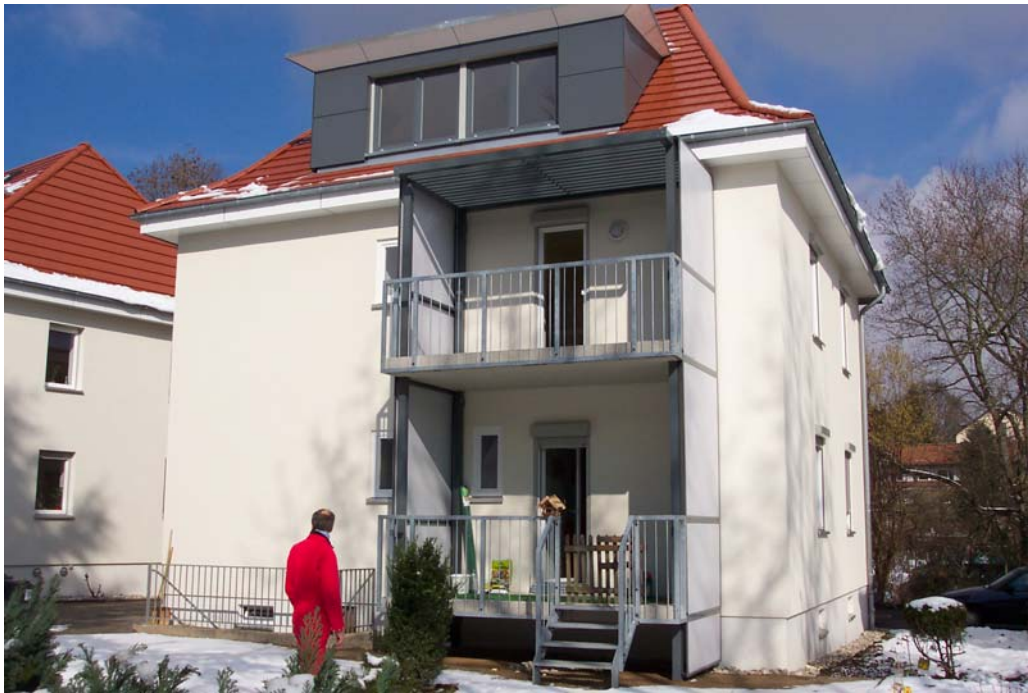
Abbildung 2.4-8 Südfassade des Gebäudes im EnEV-Neubau-Standard nach der Modernisierung
