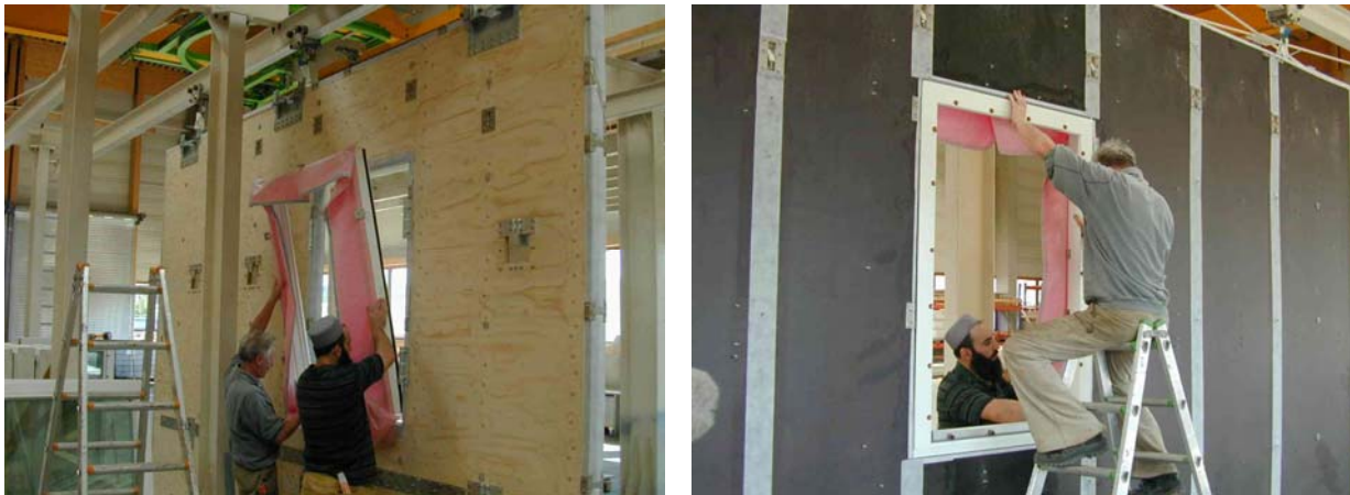
Abbildung 7.3-16 Montage des Fensters in ein GEDT
