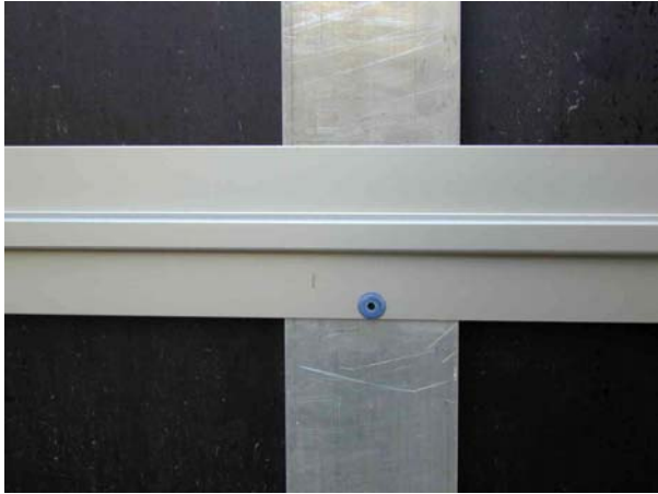
Abbildung 7.4-16: Fugenprofil der Unterkonstruktion
