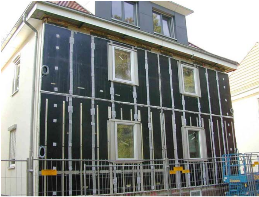
Abbildung 7.4-12: Straßenfassade nach Montage der GEDT-Elemente, vor der Befestigung der Unterkonstruktion für die Fassadenbekleidung
