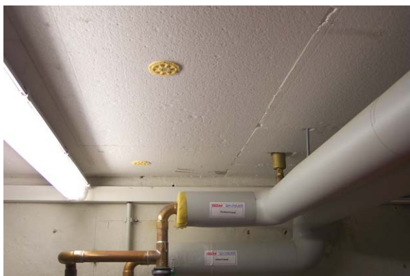
Abbildung 2.4-6 Dämmung der Kellerdecke und Befestigung mit Dübeln (während der Arbeiten)
