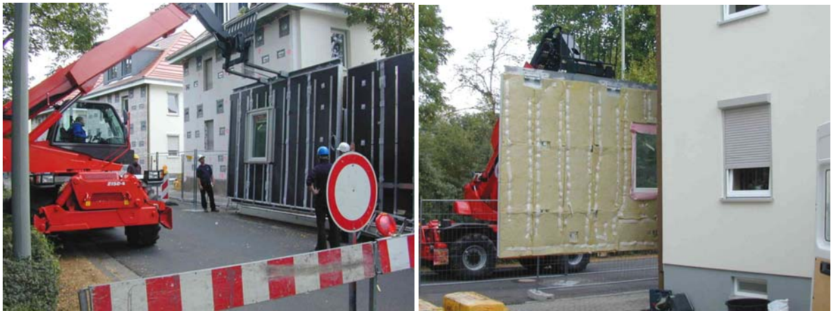
Abbildung 7.4-9 Anheben und Transport eines GEDT-Elements mit dem Teleskopstapler
