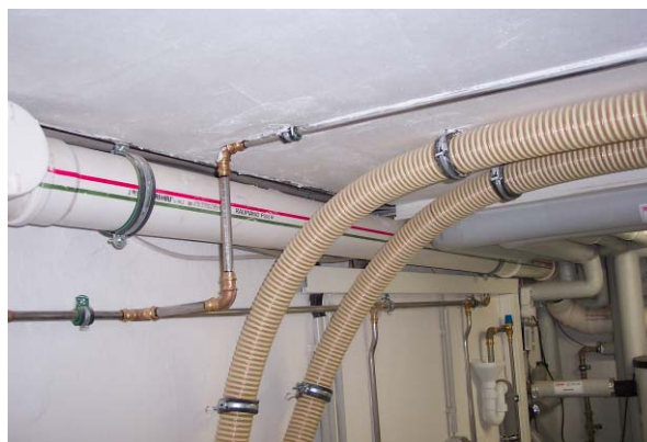
Abbildung 2.4-7 Ansicht der fertig gedämmten und gespachtelten Kellerdecke; man erkennt die beengte räumliche Situation
