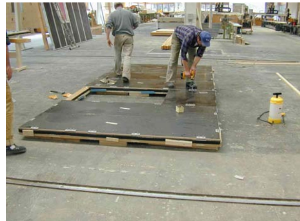
Abbildung 7.3-14 Montage der äußeren Teile der Befestigungsanker
