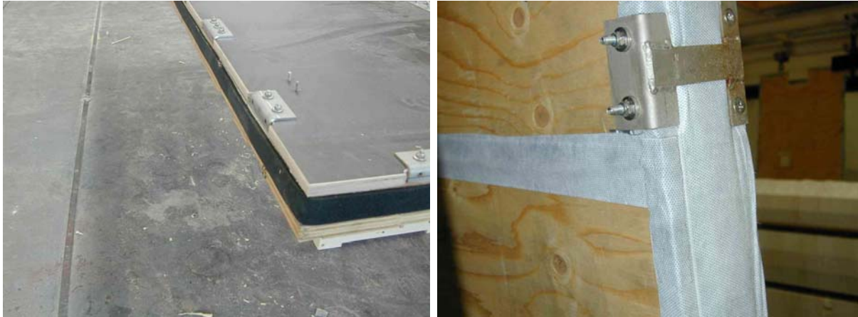
Abbildung 7.3-15 Kantenschutz der GEDT-Elemente
