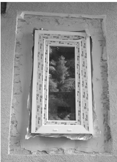
Abbildung 2.4-3 Details beim Fenstereinbau: links: das alte WDVS ist um das Fenster herum ausgeschnitten, so dass dieses direkt auf der Bestandswand befestigt werden kann rechts: Die Lücke in der Dämmung ist bis zum Vorbaurollladen geschlossen
