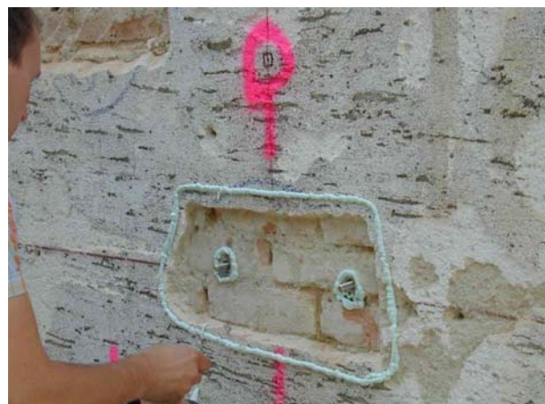
Abbildung 7.4-5 Abdichten des Wandbefestigers (W-Punkt) zur Verbesserung der Luftdichtheit
