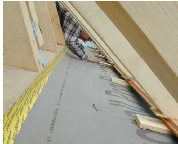
Abbildung 3.2-4: Foliendichtung zwischen Fußpfette und Aufschiebling
