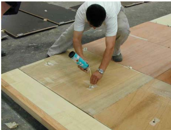
Abbildung 7.3-13 Ausschäumen von Fugen und Hohlräumen mit PU-Ortschaum
