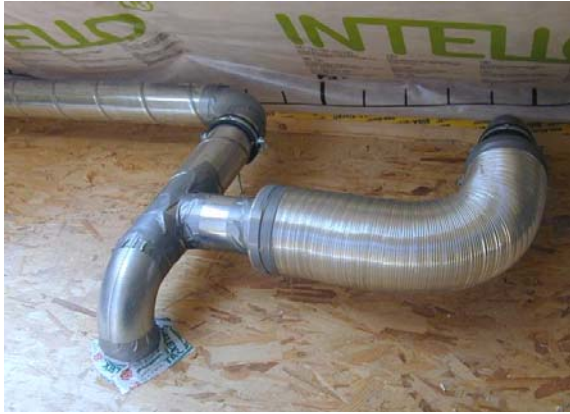
Abbildung 2.5-8: Abluftverteilung im Spitzboden
