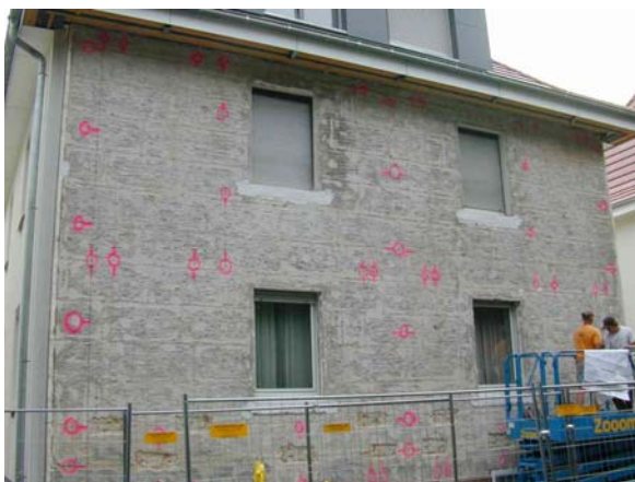
Abbildung 7.4-1: Ansicht der Gebäude vor Montage der Befestigungspunkte; links EnEV-Neubau, rechts ESH 40; die Markierungen zeigen die spätere Lage der Befestigungspunkte
