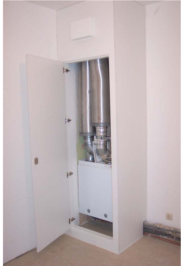
Abbildung 2.5-11: Lüftungsgerät fertig eingebaut
