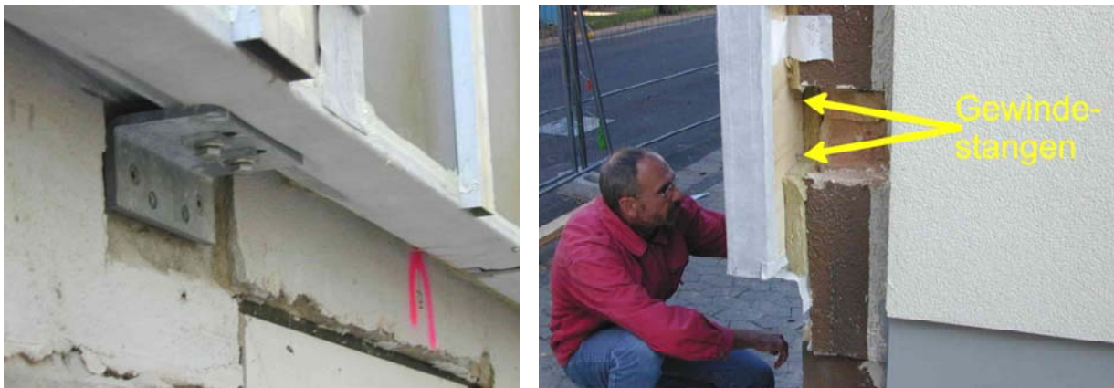
Abbildung 7.4-13: Detailansicht von M-Punkt (links) und K-Punkt (rechts)
