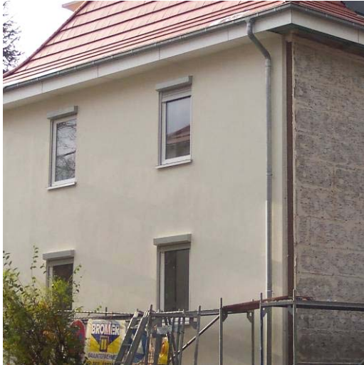
Abbildung 3.2-9: Außen auf- gesetzte Rollladenkästen, hier beim Gebäude im EnEV-Neubau-Standard
