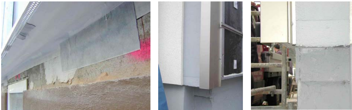
Abbildung 7.4-21 Abdichtung der GEDT-Elemente an den Sockelbereich (links) sowie Schließen der Arbeitsfuge zum WDVS (Mitte) und Anschluss der Perimeterdämmung (rechts)
