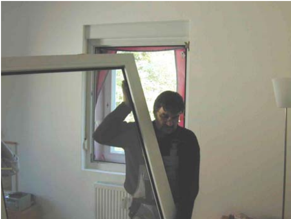
Abbildung 7.4-19: Demontage der alten Fenster
