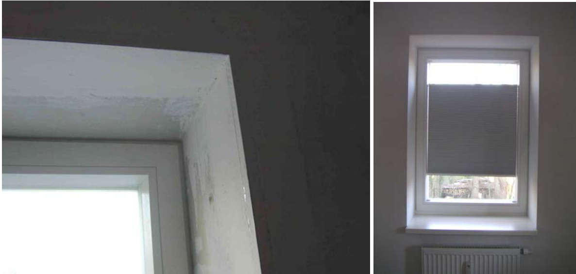
Abbildung 7.4-20 Fensterleibung mit Verkleidung aus Gipskarton (links) und fertiges Fenster mit Verdunklung (rechts)
