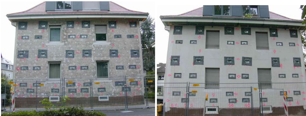
Abbildung 7.4-7 Ansicht der Fassade mit montierten Wandbefestigern; links EnEV-Neubau, rechts ESH 40
