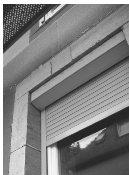
Abbildung 2.4-3 Details beim Fenstereinbau: links: das alte WDVS ist um das Fenster herum ausgeschnitten, so dass dieses direkt auf der Bestandswand befestigt werden kann rechts: Die Lücke in der Dämmung ist bis zum Vorbaurollladen geschlossen
