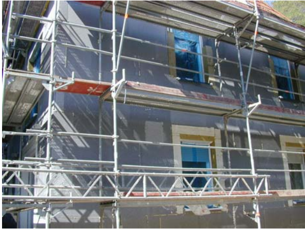
Abbildung 2.4-5 Montage des Wärmedämmverbundsystems beim Energiesparhaus 40, links: Gesamtansicht, rechts: 20 cm neues auf 5 cm altem WDVS
