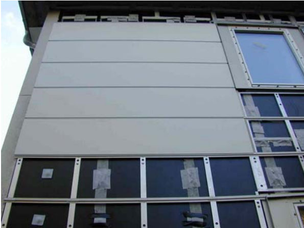
Abbildung 7.4-18 Montageablauf der Harzkomposit-Platten
