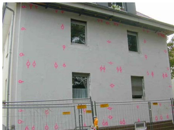
Abbildung 7.4-1: Ansicht der Gebäude vor Montage der Befestigungspunkte; links EnEV-Neubau, rechts ESH 40; die Markierungen zeigen die spätere Lage der Befestigungspunkte
