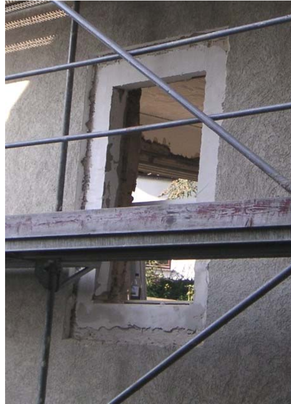
Abbildung 3.2-8: Glattstrich auf Fensteranschlagn als Untergrund für Abdichtung
