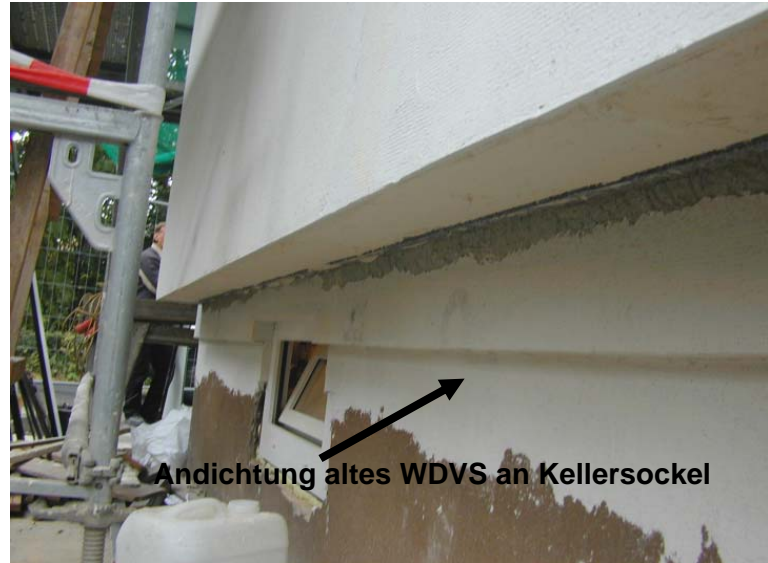
Abbildung 3.2-2 Andichtung des alten WDVS (hintere Stufe) an den Kellersockel (Beton), darüber neues WDVS; anschließend wurde dieser Bereich mit Perimeterdämmung überdeckt
