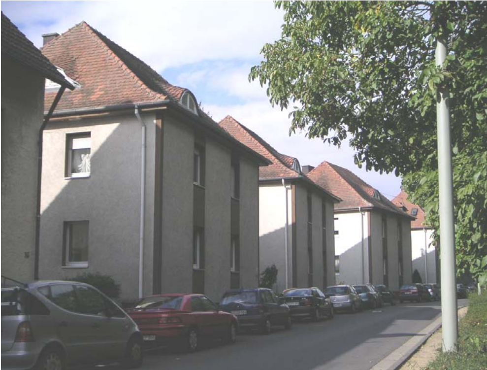
Abbildung 2.1-1 Die drei Gebäude in der Wilhelmstraße vor der Modernisierung
