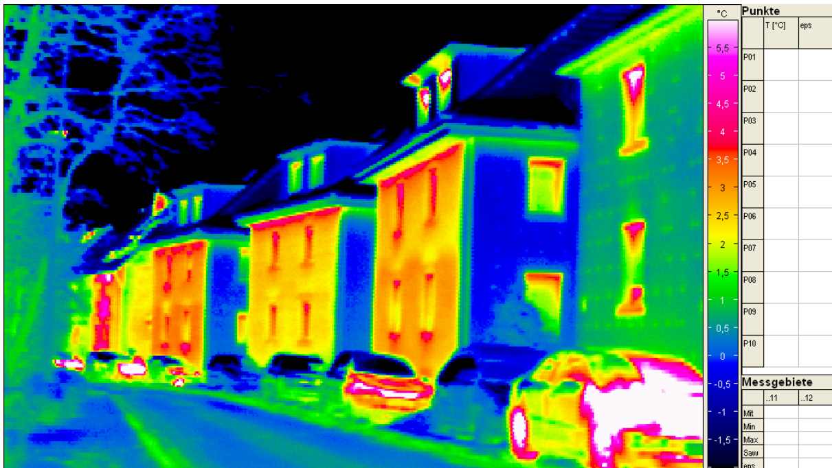
Abbildung 3.1-8 Ansicht der noch ungedämmten Straßenfassaden drei Gebäude
