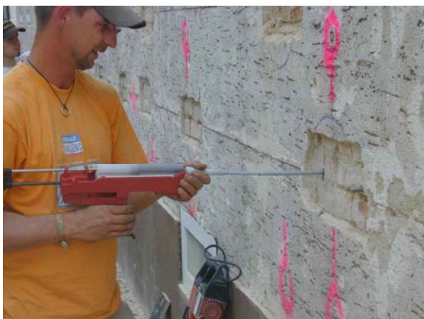
Abbildung 7.4-4 Montage der Spezialdübel
