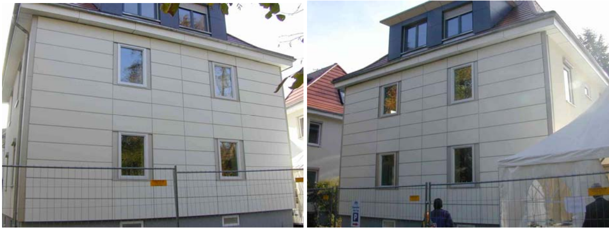
Abbildung 7.4-22: Ansicht der fertigen Straßenfassaden mit GEDT-Elementen
