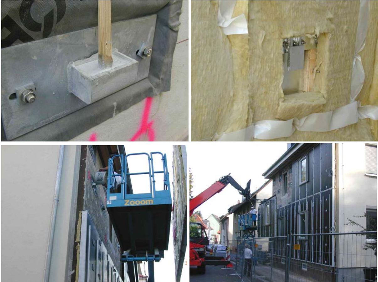
Abbildung 7.4-11 W-Punkt (Wandseite) mit Testfüllung aus Vergussmörtel (links oben) und GEDT-seitigem Gegenstück (rechts oben) sowie Füllen des W-Punkts (links unten) und Montage des letzten GEDT-Elements
