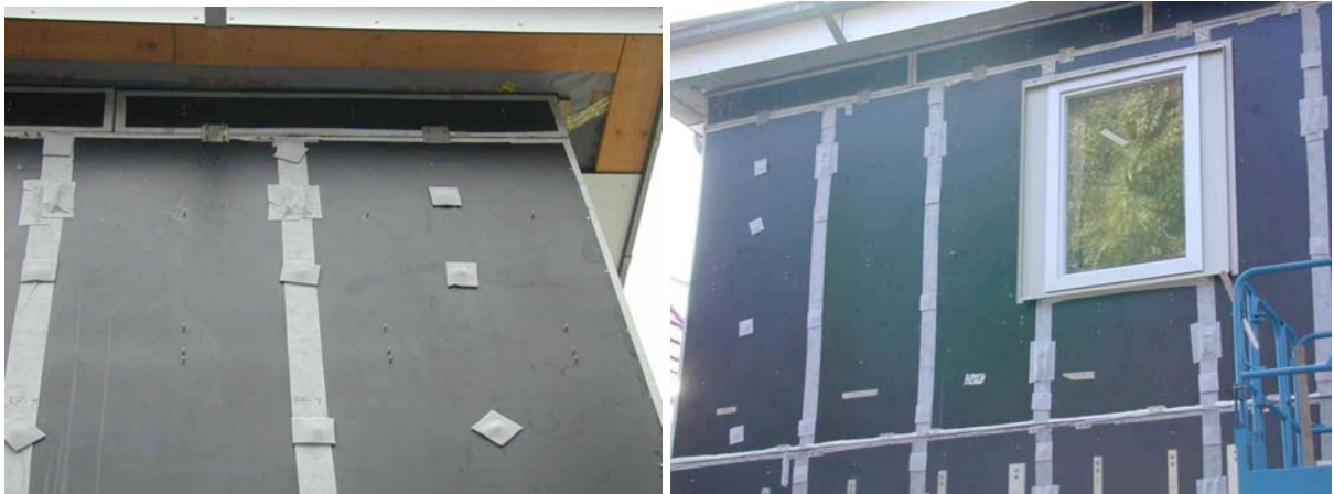
Abbildung 7.4-15: Ansicht des Füll-GEDT am Dachüberstand
