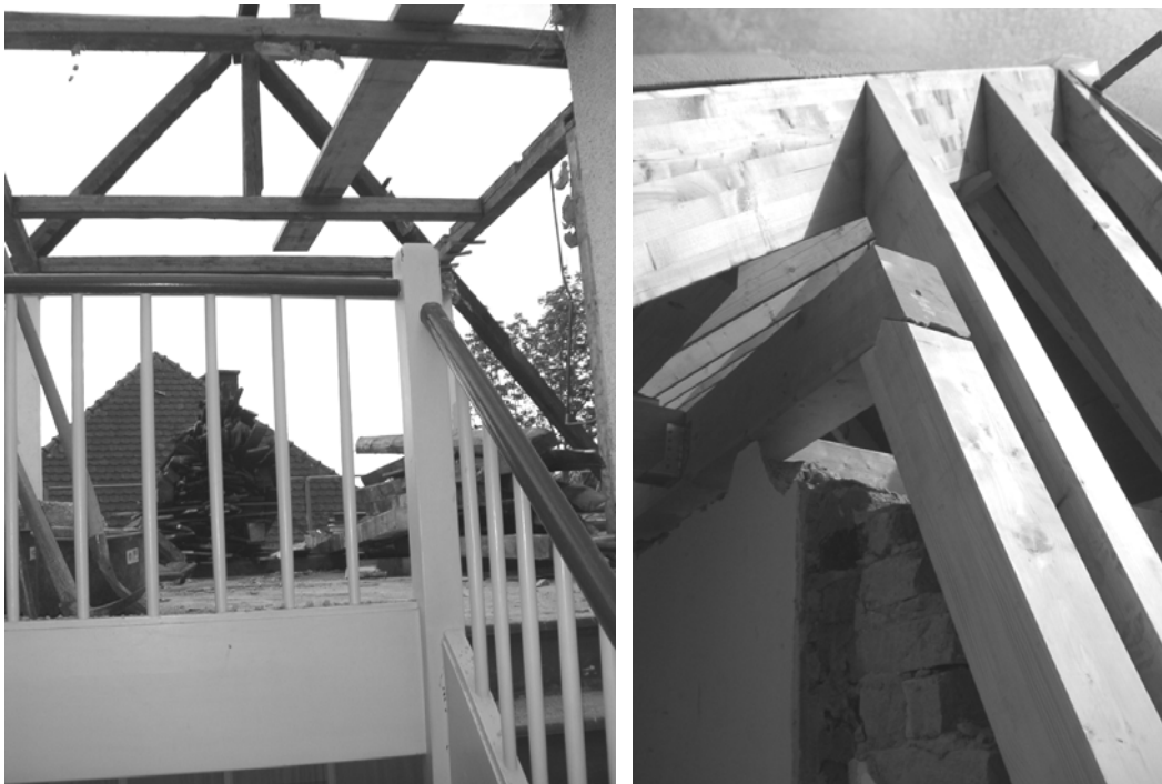
Abbildung 2.4-1 Errichtung des neuen Dachstuhls
