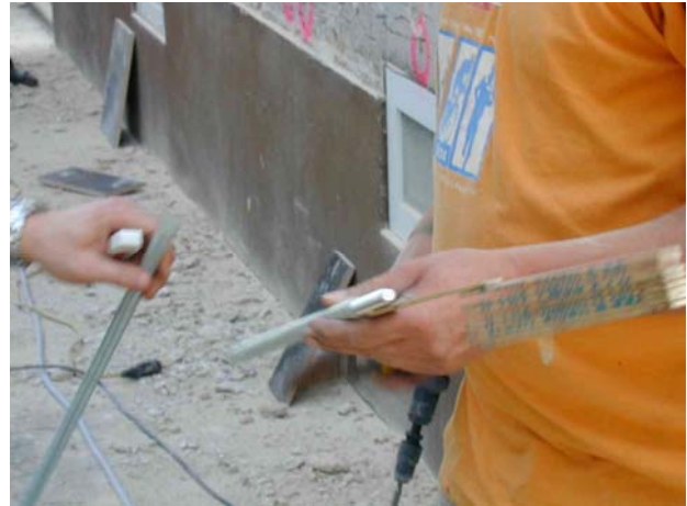
Abbildung 7.4-3 Abmessen der Spezialdübel für die Wandbefestiger
