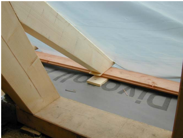
Abbildung 3.2-5: Wilhelmstraße 37 - Folie vor Montage der Aufschieblinge um die Deckenbalken gelegt und an die Fußfette angedichtet
