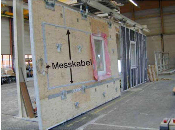
Abbildung 7.3-19 Ansicht eines fertigen GEDT-Elements (Wandseite) und der Messtechnik
