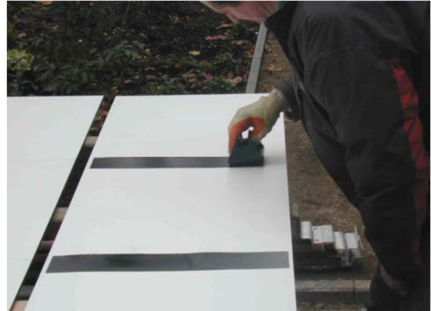
Abbildung 7.4-17: Primern der Harzkomposit-Platten an den Klebestellen
