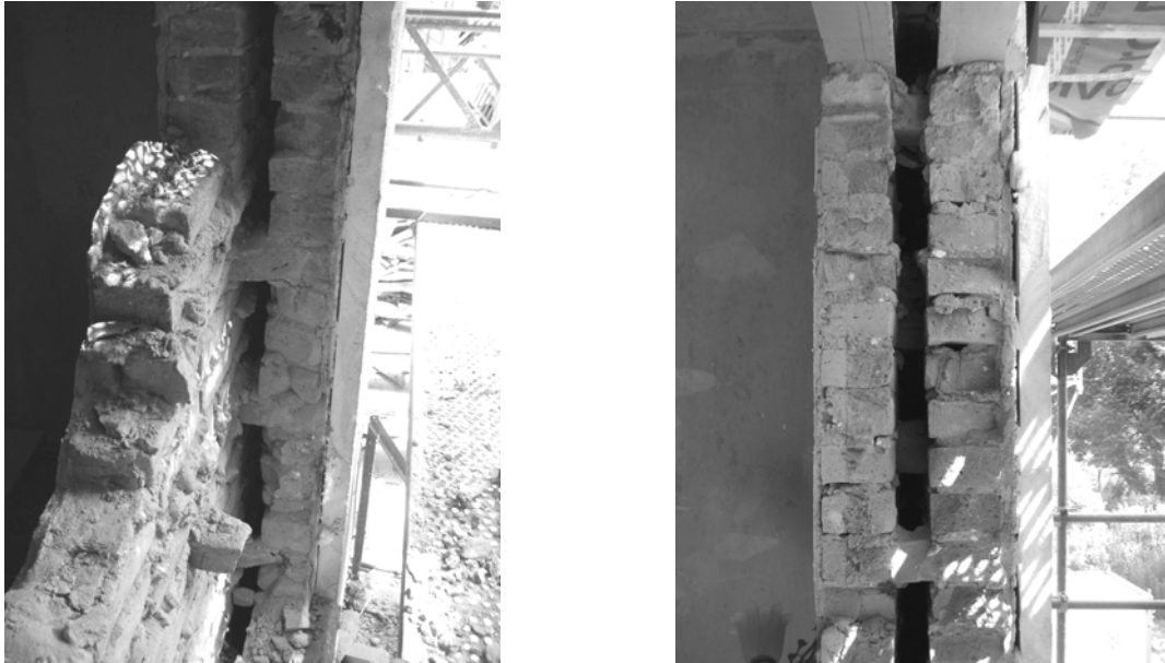
Abbildung 2.4-4 Altbauwände mit zweischaligem Mauerwerk
