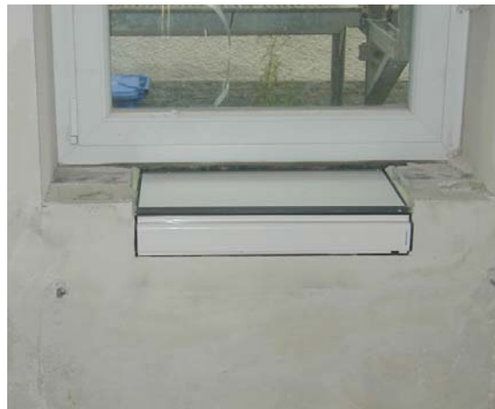
Abbildung 2.5-7 Innenansicht des Fensterbanklüfters
