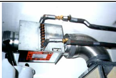
Lufterhitzer mit Filter bei Mittelhaus
