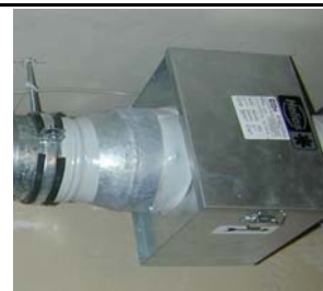
Lufterhitzer mit Filter bei Mittelhaus
