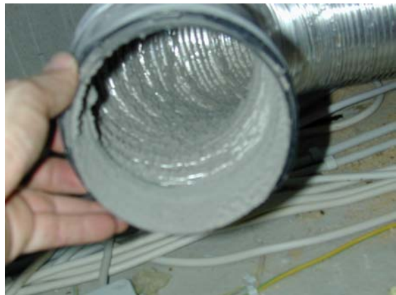
Blick in den Abluftkanal an der Ventilatorbox
