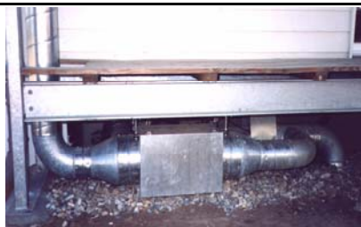
Filterkasten Frischluft
