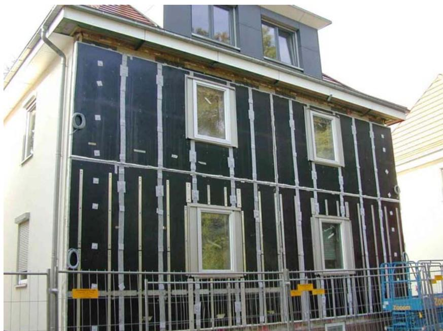
**Abbildung 3.2-13: Straßenfassade nach Montage der GEDT-Elemente, vor der Befestigung der Unterkonstruktion für die Fassadenbekleidung**
