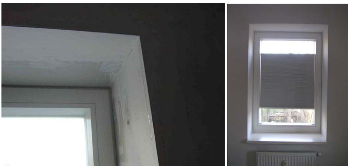
**Abbildung 3.2-22: Fensterleibung mit Verkleidung aus Gipskarton (links) und fertiges Fenster mit Verdunklung (rechts)**
