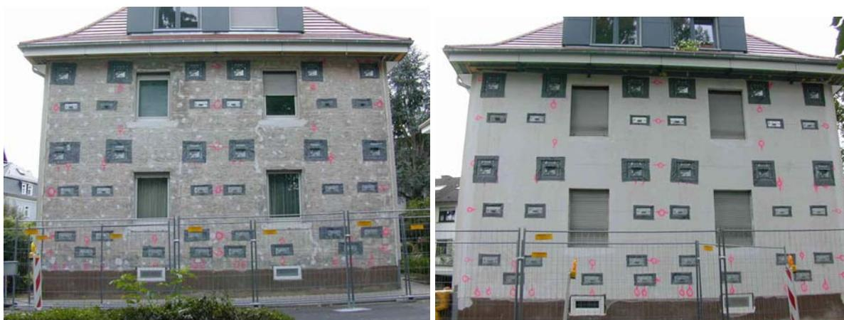
**Abbildung 3.2-7: Ansicht der Fassade mit montierten Wandbefestigern; links EnEV-Neubau, rechts ESH40**
