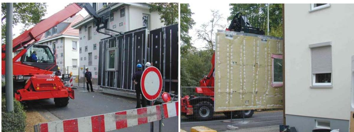
**Abbildung 3.2-9: Anheben und Transport eines GEDT-Elements mit dem Teleskopstapler**
