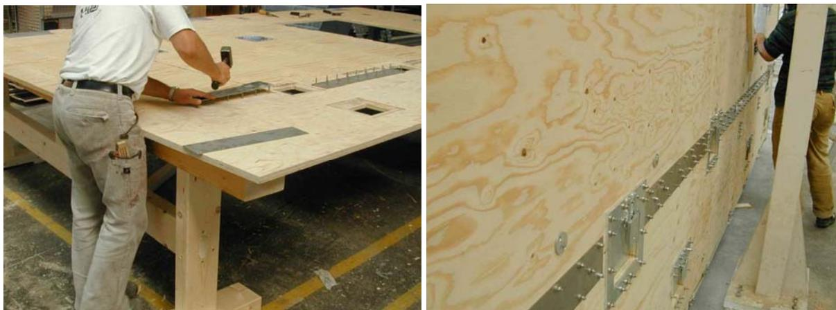
**Abbildung 3.3-4: Verlängerung der unteren Elemente (Kerto-Schicht)**
