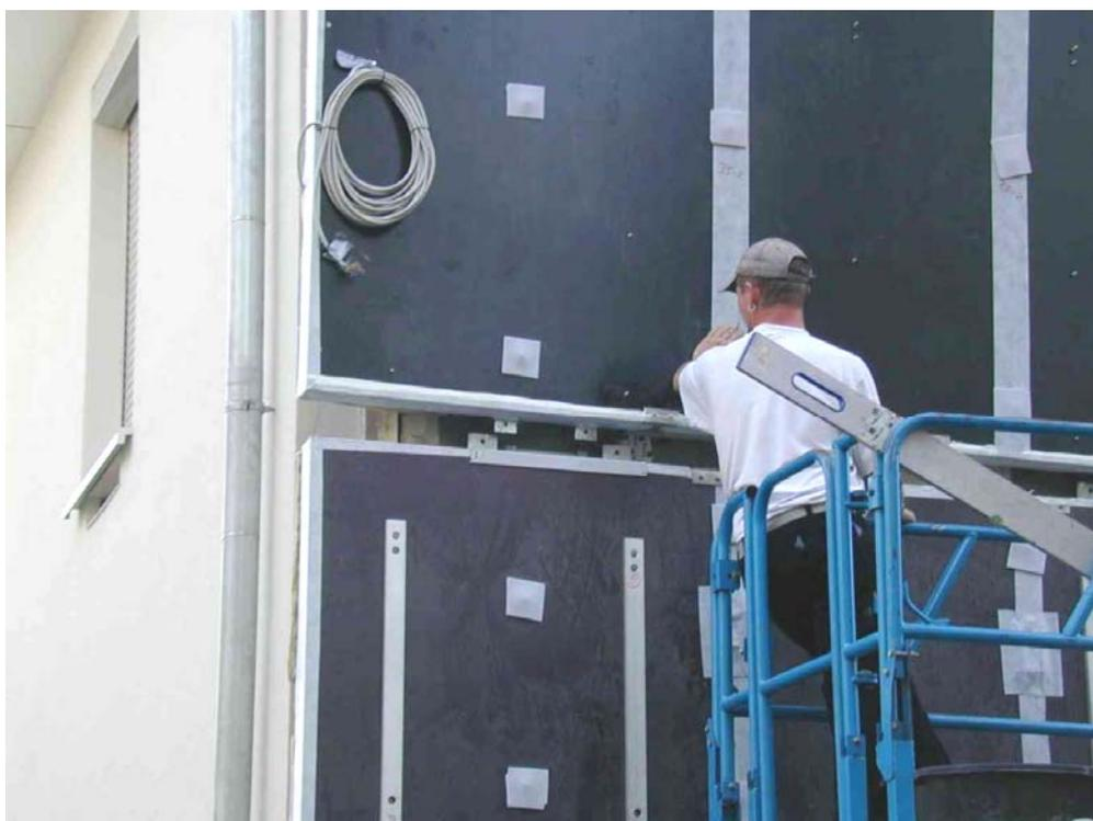
**Abbildung 3.3-5: Rand von zwei Elementen bei der Montage: Der Dorn des U-Punkts (vgl. Abbildung 2.2-10) des oberen Elements greift in die Klammer an der Oberseite des E-Punktes des unteren Elementes. In der Elementmitte konnte dies wie gesagt bei vier GEDT-Elementen nicht realisiert werden, die Dorne der U-Punkte mussten dort jeweils entfernt werden.**
