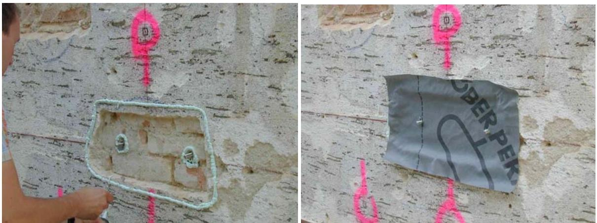
Abbildung 3.2-5: Abdichten des Wandbefestiger (W-Punkt) zur Verbesserung der Luftdichtheit
