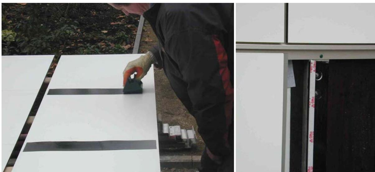
**Abbildung 3.2-18: Primern der Harzkomposit-Platten an den Klebestellen (links) und doppelseitiges Klebeband (rechts) zur Fixierung der Platten**
