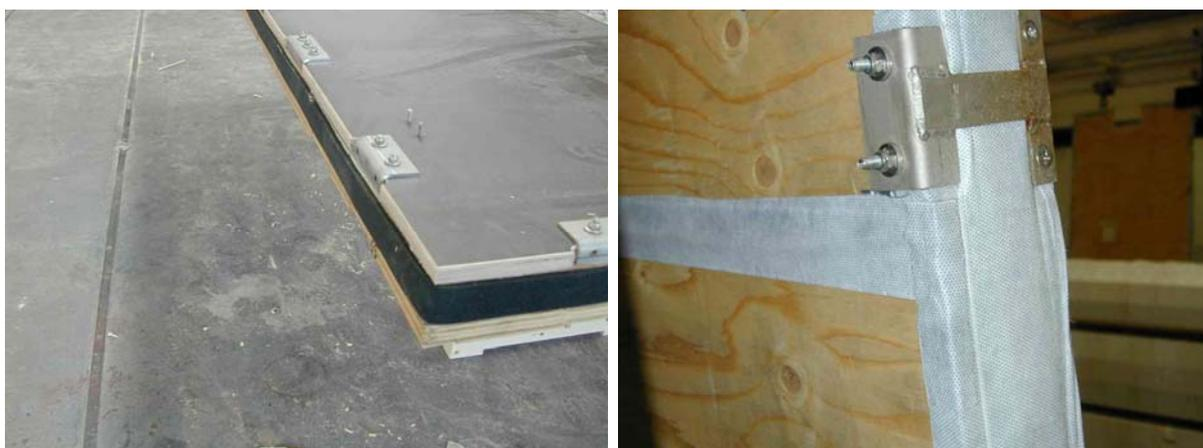
**Abbildung 3.1-20: Kantenschutz der GEDT-Elemente**
