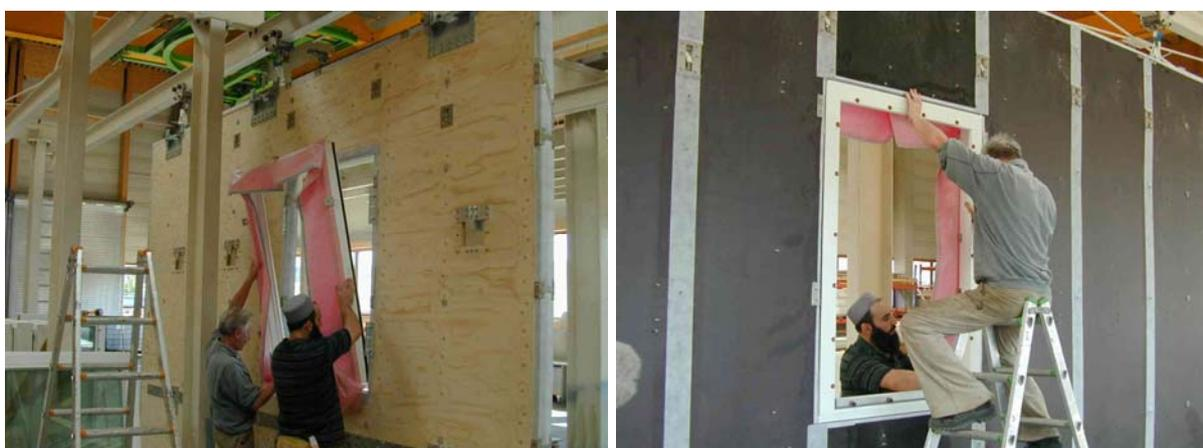
**Abbildung 3.1-21: Montage des Fensters in ein GEDT**
