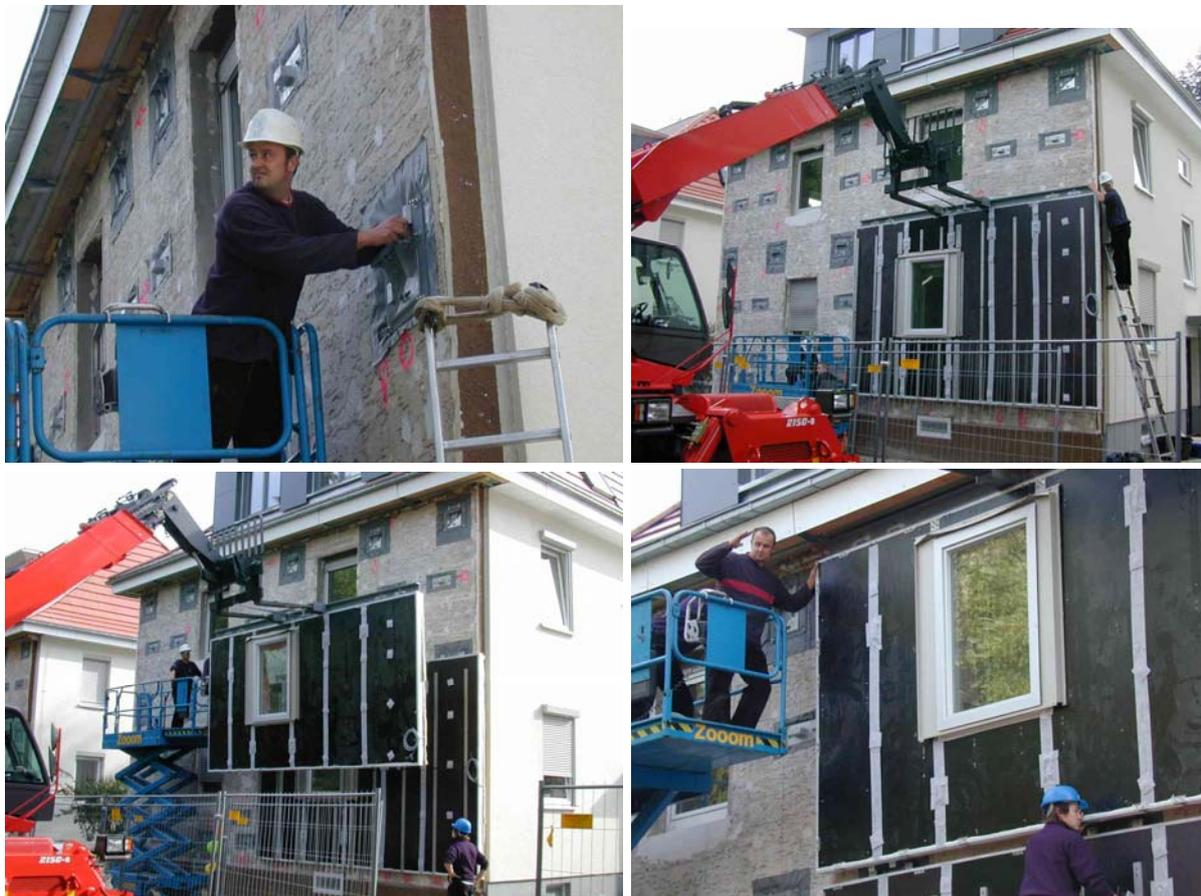
Abbildung 3.2-10: Montage des ersten und zweiten GEDT-Elements
