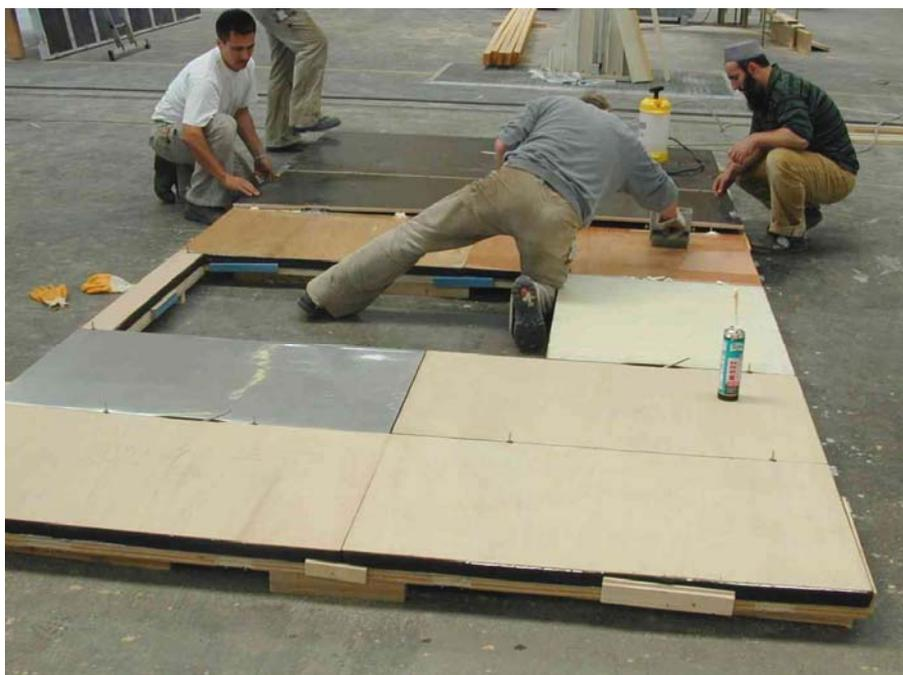
**Abbildung 3.1-16: Verkleben der BFU-Platten auf die VIPs**
