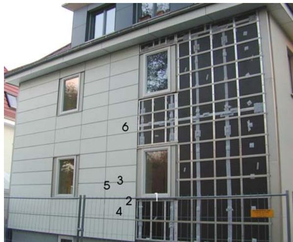
Position der Fühler als Projektion auf Außenseite der Fassade
