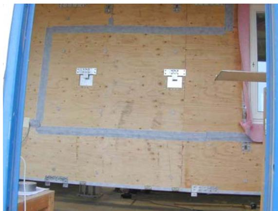
Zum Schluss werden Fühler und Kabel mit Butylklebeband geschützt
