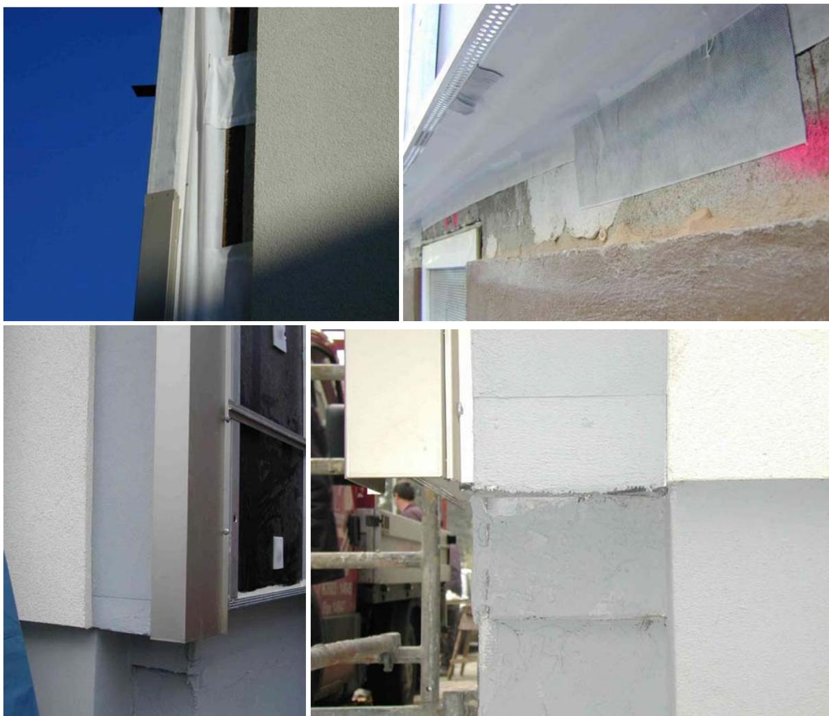
**Abbildung 3.2-23: Abdichtung der GEDT-Elemente an das WDVS (oben links) und an den Perimeter (oben rechts) sowie Schließen der Arbeitsfuge zum WDVS (unten links) und Anschluss der Perimeterdämmung (unten rechts)**
