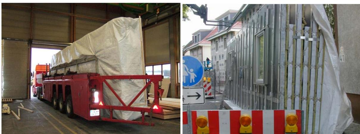
**Abbildung 3.2-8: Ansicht des Transportgestells der GEDT mit sechs Elementen**
