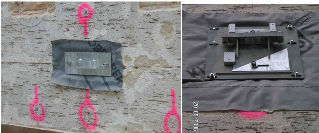
Abbildung 3.2-6: Ansicht montierter Befestigungspunkte: links W-Punkt, rechts E-Punkt
