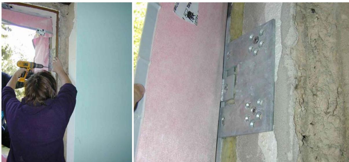
**Abbildung 3.2-21: Befestigung der Fenster in der Leibung (links) und Abdichten mit einem Folienlappen (rechts)**
