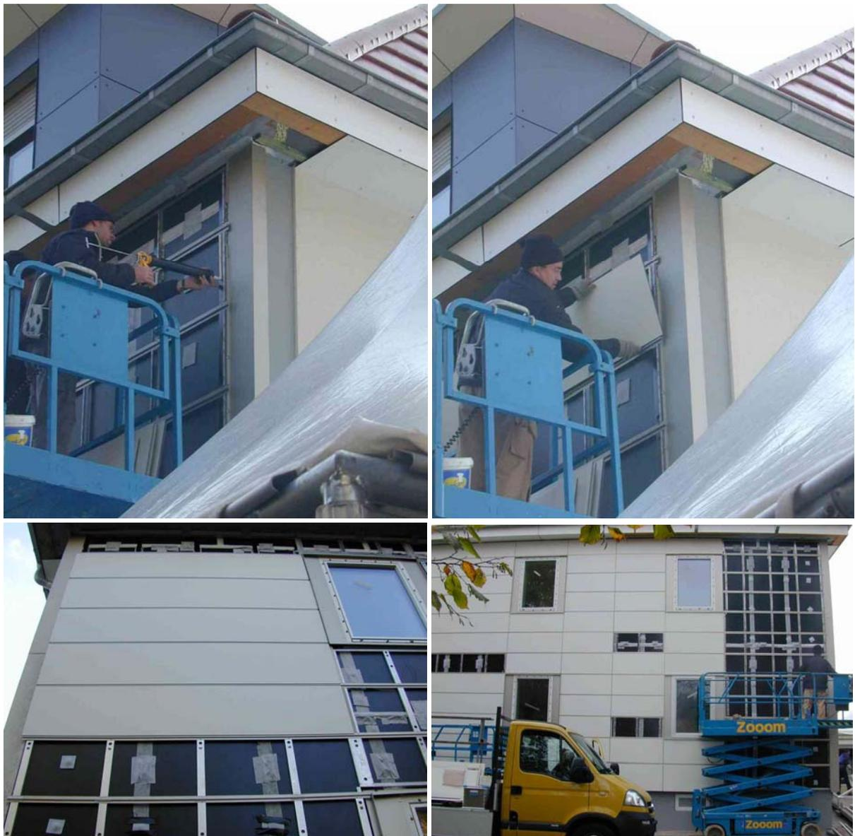
**Abbildung 3.2-19: Montageablauf der Harzkomposit-Platten**
