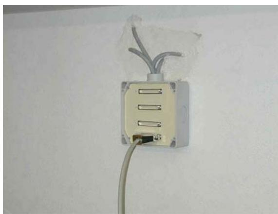
Fertiger Anschlusskasten mit Stecker zur Messung
