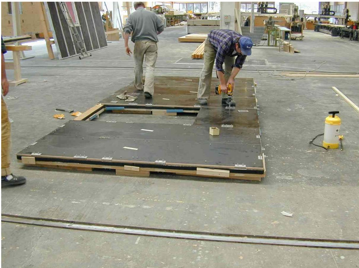
**Abbildung 3.1-18: Montage der äußeren Teile der Befestigungsanker**
