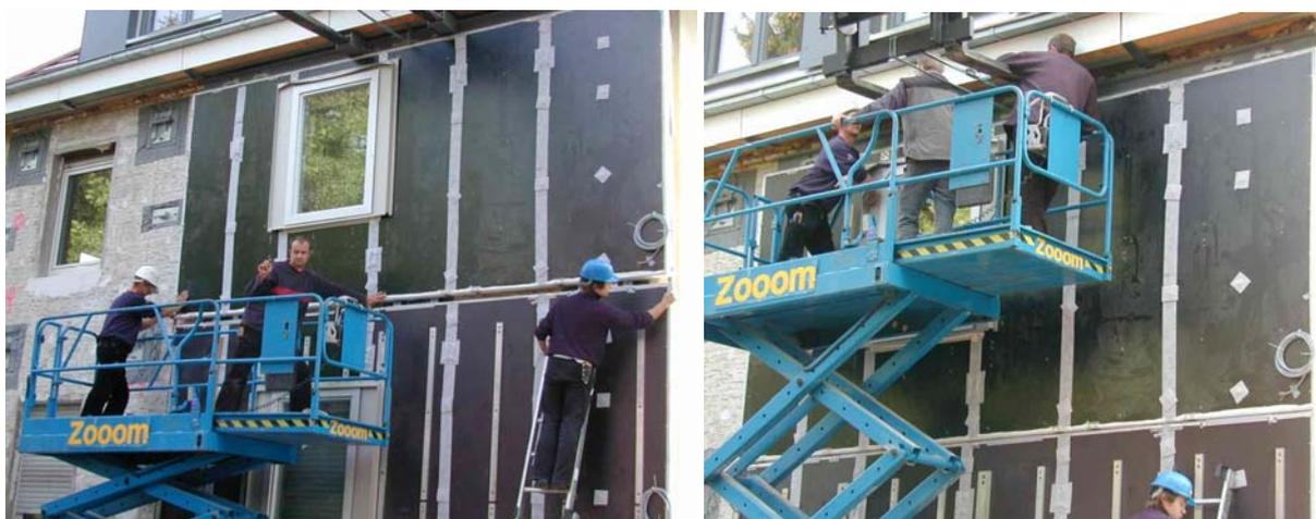
Abbildung 3.2-11: Ausrichten des oberen Elementes
