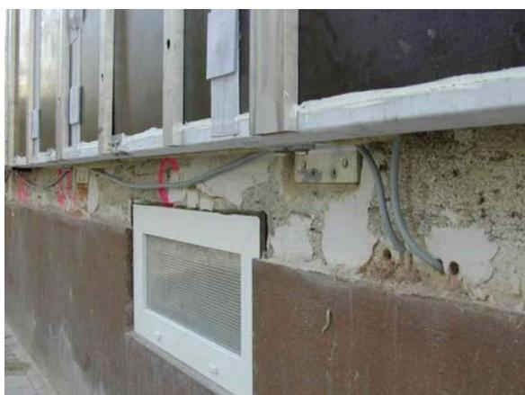
Das Rundkabel beim Verlegen hinter dem GEDT in den Keller
