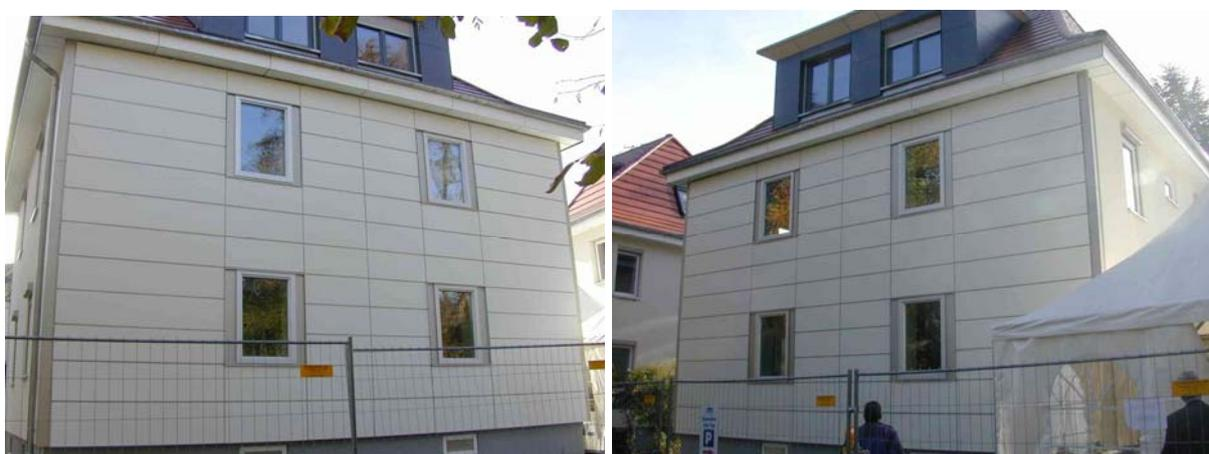
**Abbildung 3.2-24: Ansicht der fertigen Straßenfassaden mit GEDT-Elementen**
