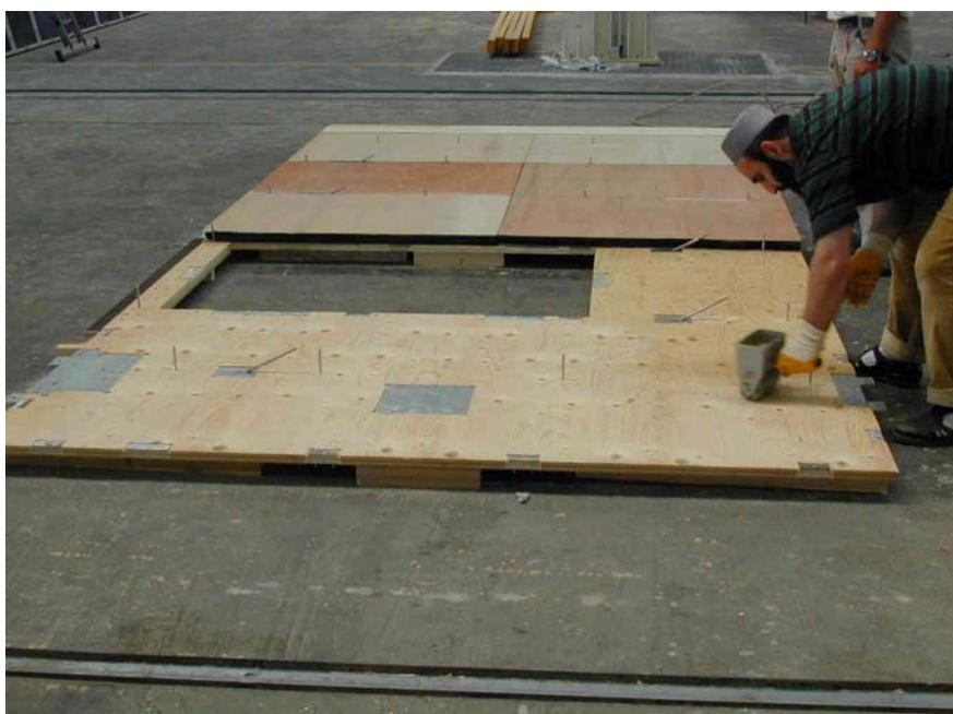
**Abbildung 3.1-14: Auftragen des PU-Klebers auf die Kerto-Platte**
