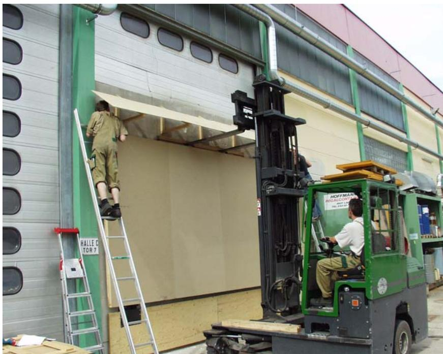
**Abbildung 3.1-2: Prototyp II: Montage unter einer Attrappe für den Dachüberstand**
