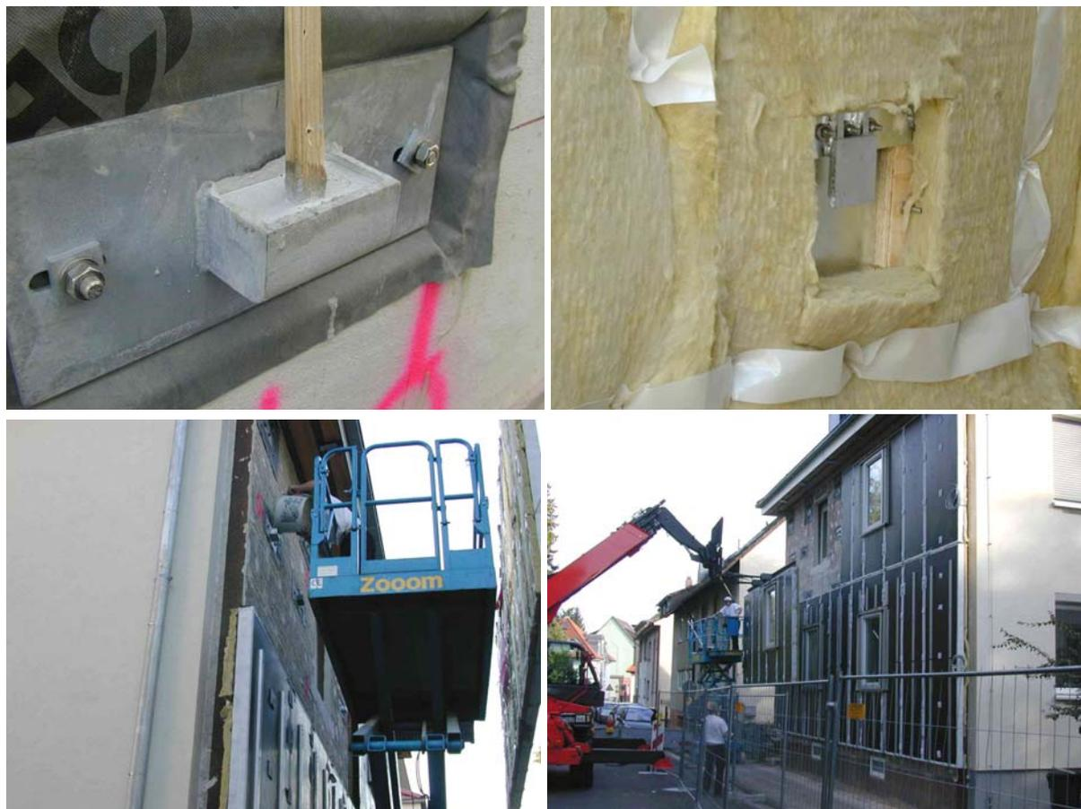
**Abbildung 3.2-12: W-Punkt (Wandseite) mit Testfüllung aus Vergussmörtel (links oben) und GEDT-seitigem Gegenstück (rechts oben) sowie Füllen des W-Punkts (links unten) und Montage des letzten GEDT-Elements**
