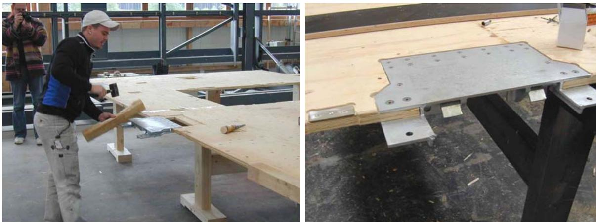
**Abbildung 3.1-11: Montage des E-Punktes in die Kerto-Platte**
