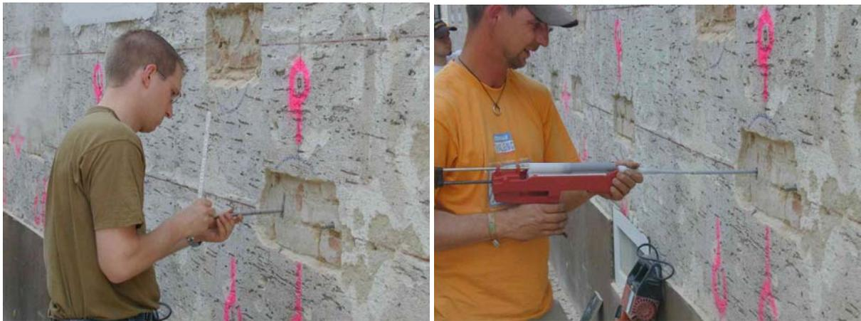
Abbildung 3.2-4: Montage der Spezialdübel
