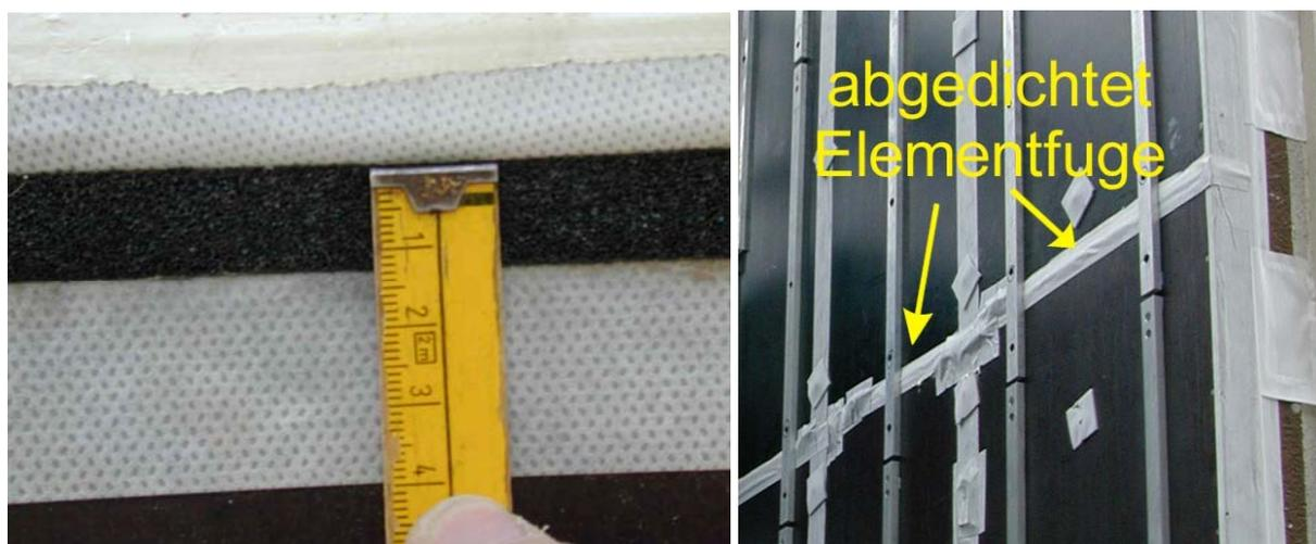
**Abbildung 3.2-15: Detail einer GE-GE-Fuge (links, Blick auf Kompriband) und abgedichtete Elementfuge (rechts)**
