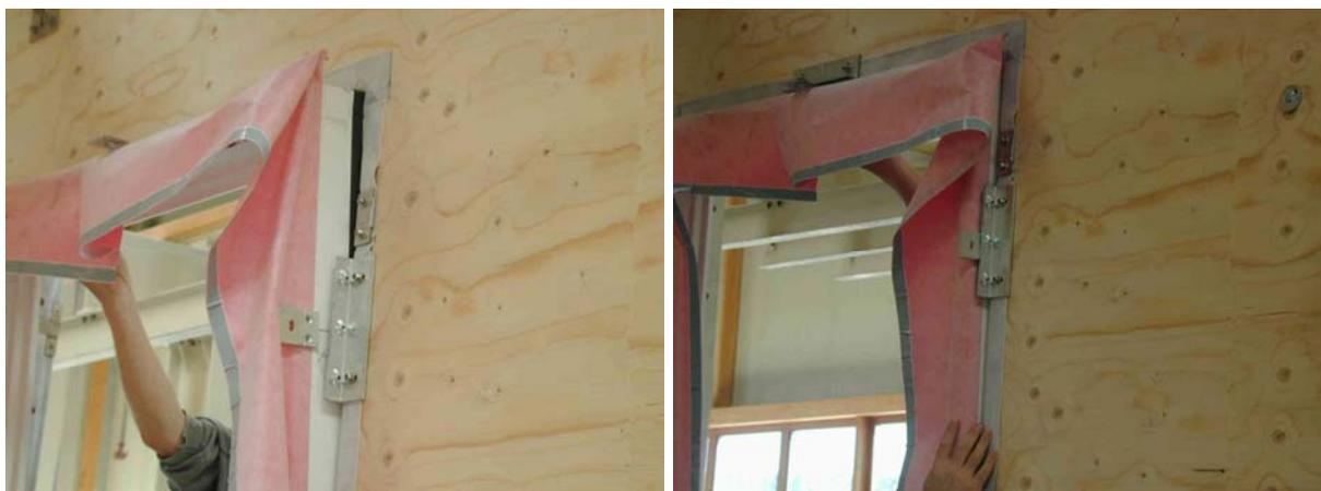
**Abbildung 3.1-22: Einbau des Fenster in ein GEDT – Details Abdichtung**
