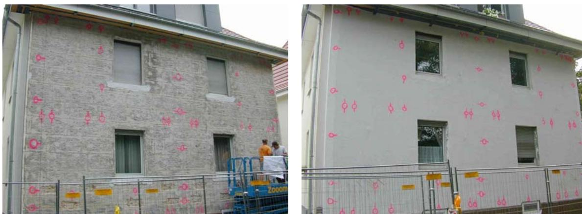
Abbildung 3.2-1: Ansicht der Gebäude vor Montage der Befestigungspunkte; links EnEV-Neubau, rechts ESH40; die Markierungen zeigen die spätere Lage der Befestigungspunkte
