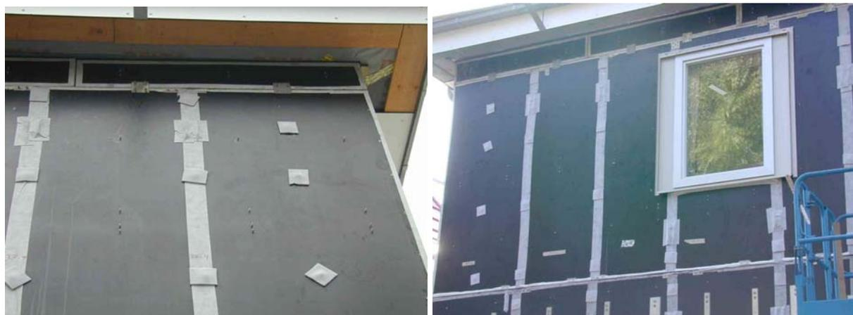
**Abbildung 3.2-16: Ansicht des Füll-GEDT am Dachüberstand**
