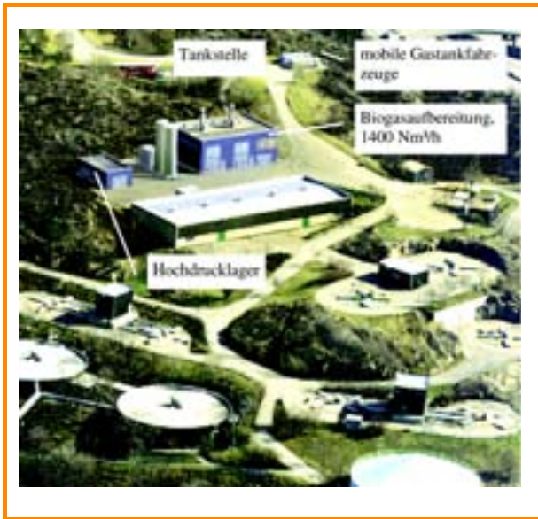
Abb. 2-16: Ansicht der Biogasaufbereitungsanlage Stockholm-Henriksdal
