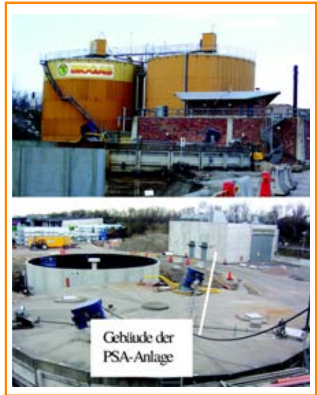
Abb. 2-19: Biogasanlage mit Biogasaufbereitung in Helsingborg
