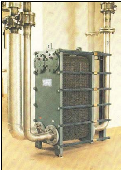
Abbildung 13-2: Plattenwärmetauscher [SIROCCO]
