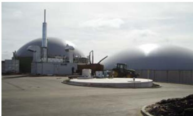
Abb. 49: Güllevorgrube, Fermenter und Nachgärbehälter
