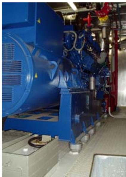
Abb. 52: Motor-Generator-Kombination des Blockheizkraftwerkes (BHKW)
