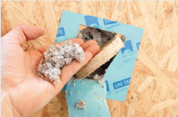
*Einfüllöffnung für die Zellulosedämmstoffe in den Außenwänden (Einblasverfahren)*
