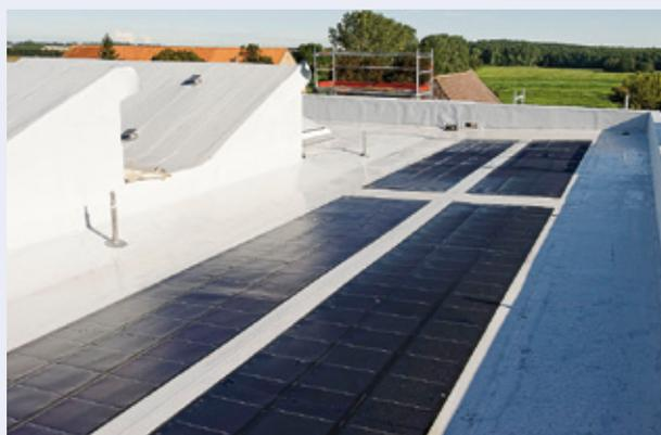
Dachbahnen mit integrierten Fotovoltaik-Elementen
