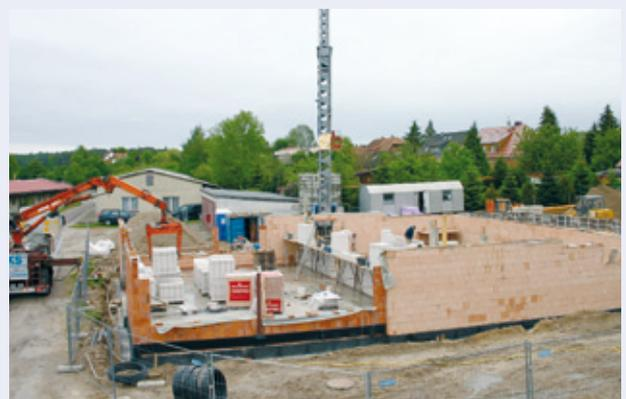
*Einbau von hochdämmenden Mauerziegeln im Erdgeschoss*
