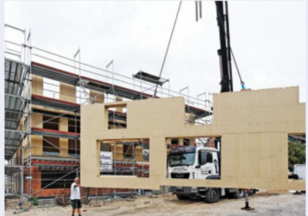
*Kranentladung und Montage der vorgefertigten Wandelemente*
