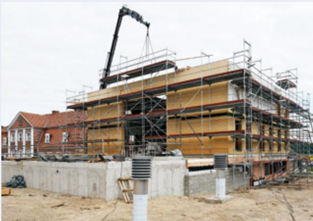
*Auch die Decken- und Dachkonstruktion wurden vorgefertigt angeliefert und montiert*
