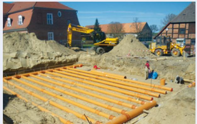
*Verlegung von Zuluftrohren unter der Sohlplatte*
