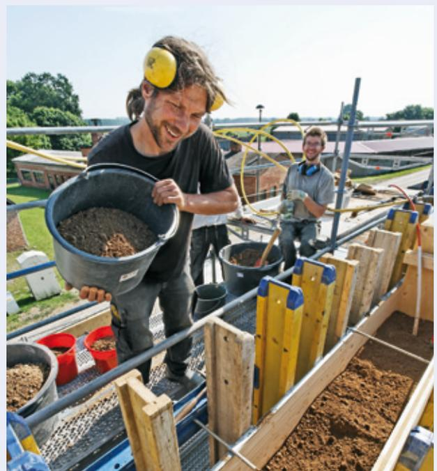
*Auch im Schalungsbau werden moderne Holzwerkstoffe verwendet (3-Schichtplatten und Stegträger aus Holz)*
