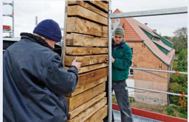
*Zu transportablen Elementen vorgefertigt, ließen sich die Elemente mit dem Kran an Ort und Stelle heben und dort befestigen*
