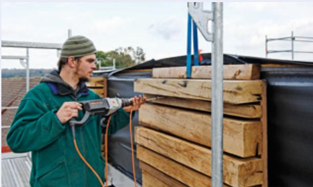
*Befestigung der Elemente mit Edelstahlschrauben*
