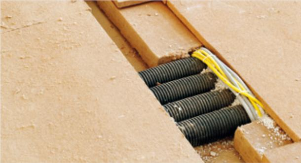
*Leitungsführungen im Holzfaserdämmstoff unter dem Estrich*
