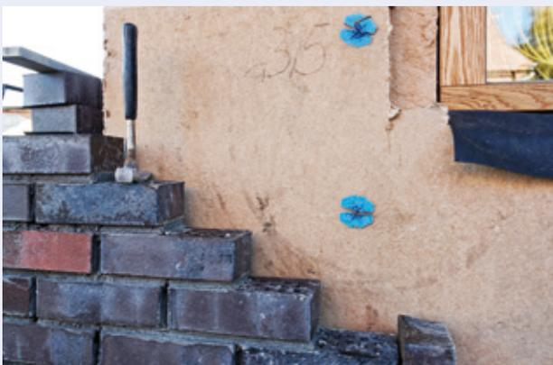
*Im Sockelbereich wurde hinter der Klinkerfassade ebenfalls mit einer Holzfaserdämmung gearbeitet*
