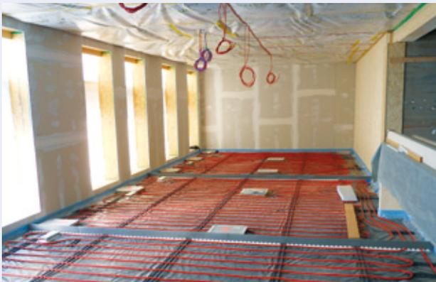
*Leitungsführung zur Bauteilaktivierung des Estrichs*
