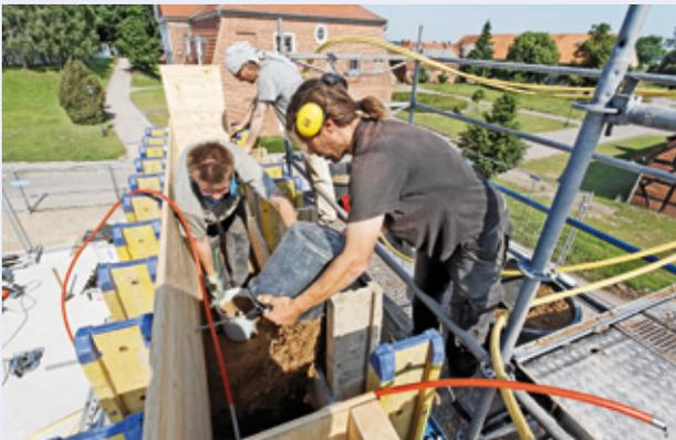
*Verschiedene Erden werden in die vorgefertigte Schalung eingebracht*
