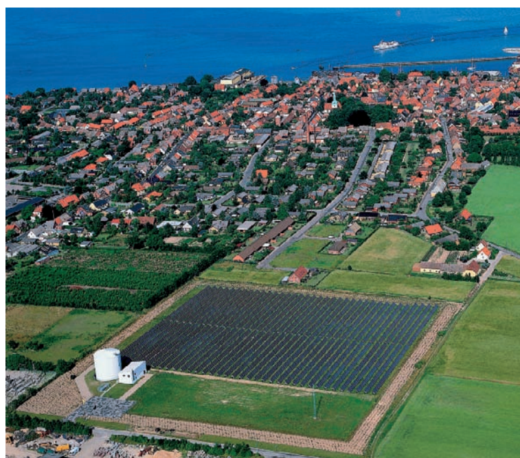
Abbildung 9 Luftbild der weltweit größten solarthermischen Anlage mit saisonalem Wärmespeicher in der Gemeinde Marstal auf der dänischen Insel Ærø
