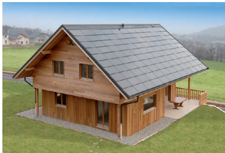
Abbildung 7 Diese von Cythelia installierte Indach- Anlage bestückt beide Dachflächen eines Wohnhauses in Frankreich.
