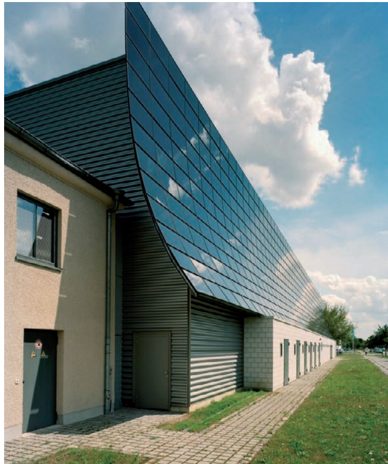
Abbildung 6 Die PV-Sichtschutz- wand des Ferdinand- Braun-Institutes für Höchstfrequenztechnik in Berlin-Adlershof besteht aus 732 Dünnschicht-Modulen mit einer Gesamt- leistung von 39 kW.
