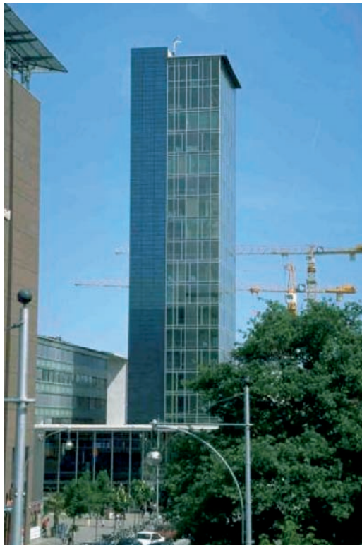
Abbildung 7 Fassadenintegrierte Photovoltaik-Anlage in Freiburg
