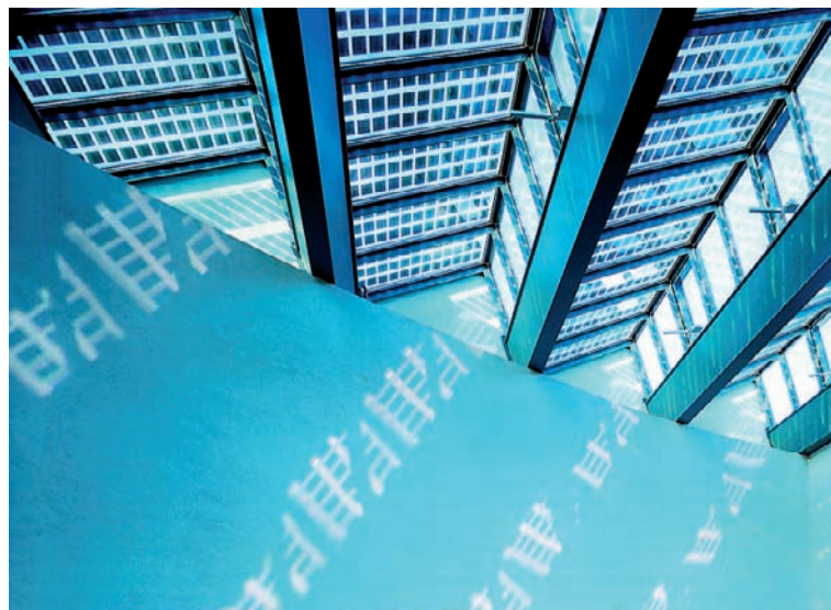
Abbildung 8 Glasintegrierte Photovoltaik-Zellen, die zugleich eine erwünschte Verschattung bewirken am Fraunhofer-ISE in Freiburg
