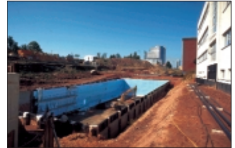
37 Kies-Wasser-Wärmespeicher in Chemnitz im Bau (ZSW, Stuttgart)
