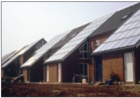
28 Ansicht der Kollektorfelder in Hamburg
