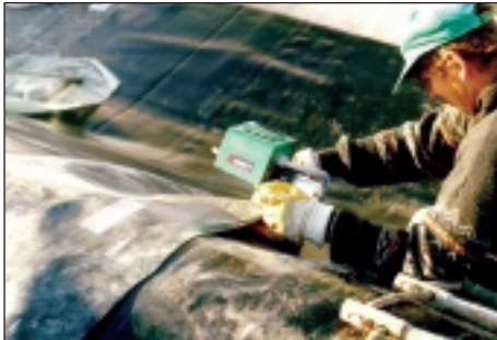
14 Verschweißen der Kunststoffolie in Steinfurt (Foto: PKI)
