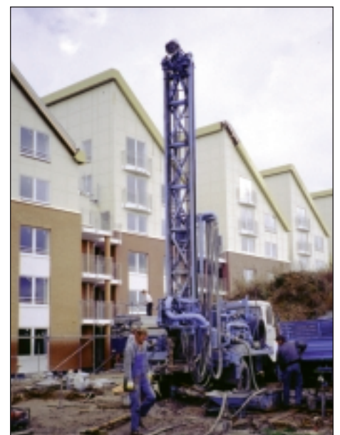
20 Bohrarbeiten in Rostock
