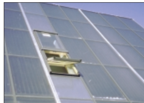
7 Solardach in Rostock-Brinckmannshöhe
