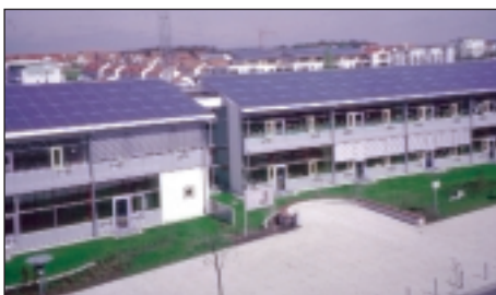
31 Ansicht des Kollektorfeldes auf der Grundschule in Neckarsulm
