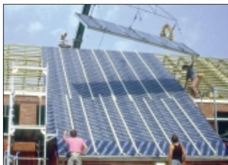
6 Montage der Kollektorflächen in Hamburg-Bramfeld
