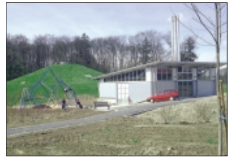
24 Heißwasser-Wärmespeicher in Friedrichshafen
