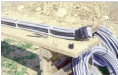
17 Doppel-U-Rohr-Sonde (Erdwärmesonde) mit Abstandshaltern und Injektionsschlauch
