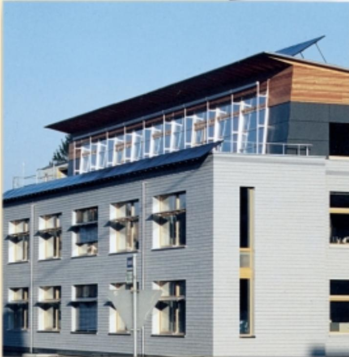
**1** Bürogebäude der Fa. Lamparter. Es zeichnet sich aus durch erhöhten Wärmeschutz, intensive Tageslichtnutzung, passive Kühlung, Wärmerückgewinnung, Erdwärme-/Erdkältenutzung und aktive Solartechnik.
