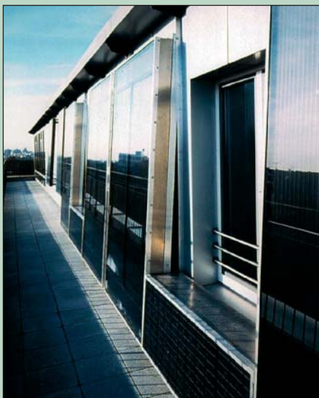
13 Luftkollektoren des MFH München
