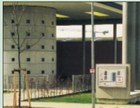
21 In einem Betonurm untergebrachter Speicher (Speicher reicht vom Boden der unterirdischen Heizzentrale bis zur oberen Decke des Turmes); sehr gute Temperaturschichtung
