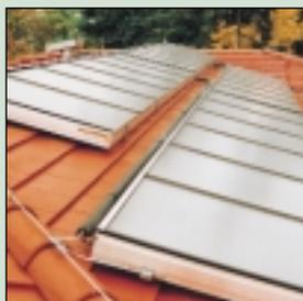
**10** Aufbau der Kollektoren oberhalb der Dachabdeckung beim Schrägdach; Vorteile: Kein Eingriff in Dachhaut; defekte Kollektoren leicht auswechselbar; Nachteile: Architektonisch nicht optimal; Keine Einsparung durch Wegfall Dacheindeckung
