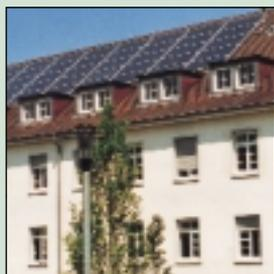
**14** Integration der Kollektoren in die Dachabdeckung beim Schrägdach; Vorteile: Architektonisch ansprechende Lösung; Einsparung durch Wegfall Dacheindeckung bei Neubauten oder Dachsanierung; Nachteile: Eingriff in Dachhaut bei Nachrüstung; Austausch defekter Kollektoren schwieriger
