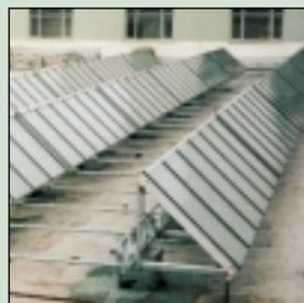
**17** Aufbau der Kollektoren auf einer leichten Stahlunterkonstruktion (Gerüstbaustangen) mit punktueller Belastung des Flachdachs; nur möglich bei kurzen Spannweiten zwischen den Auflagern; kostengünstige Lösung
