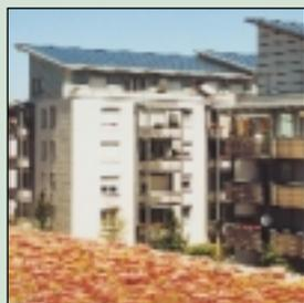
**15** Solar Roof: Dachkonstruktion vollflächig mit Kollektoren belegt (bei neuem Dach evtl. komplett vorgefertigt); Vor- und Nachteile ähnlich wie bei Schrägdachintegration
