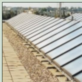
**16** Aufbau der Kollektoren auf einem flächig belastbaren Flachdach mit schweren Beton-elementen als Auflager für die Halterungskonstruktion (auch möglich z.B. mit Aluminium-Trapezblechen und Kies-Aufschüttung als Auflager); kostengünstige Lösung
