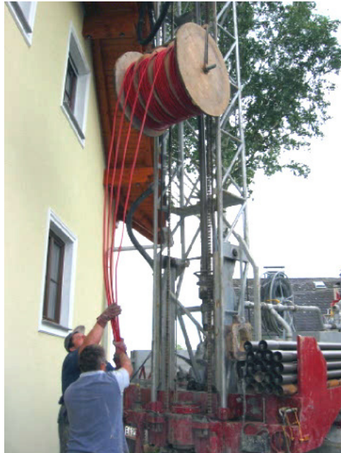
Abbildung 3: Einbringung der CO 2 -Sonden in das vorbereitete Bohrloch
