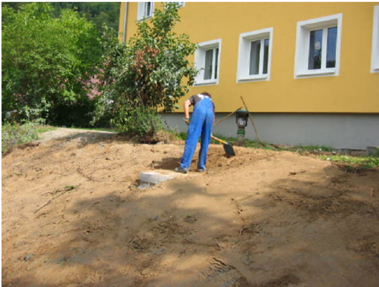
Abbildung 4: Fertigstellung der Oberfläche nach dem Einbau der CO 2 -Sonden
