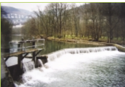
Abb. 7 Wasserkraftwerk Einsal in Altena an der Lenne (Quelle: EA-NRW)
